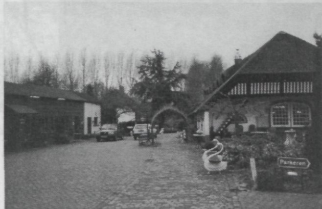
Een antiekboerderij : achterkant
