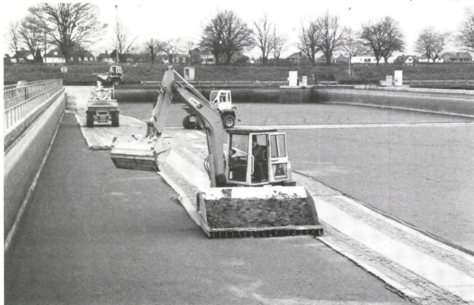
Afb. 1 - Eenmaal per 6-8 weken wordt de bovenlaag van de open langzame zandfilters in Londen verwijderd.
