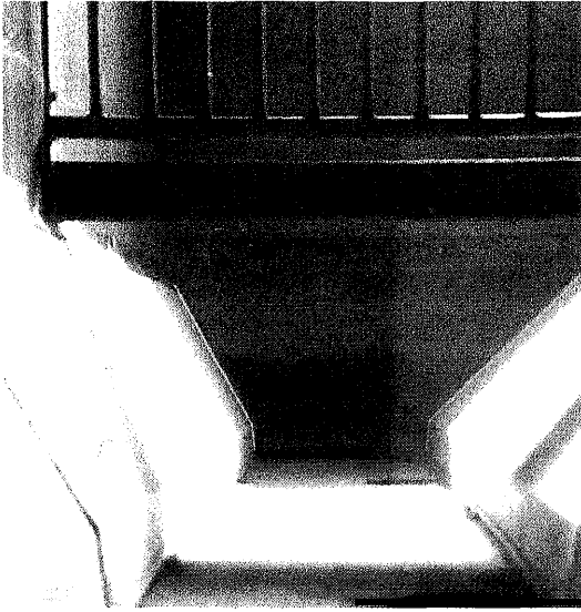
Foto 4: Schuine plaat in de put
