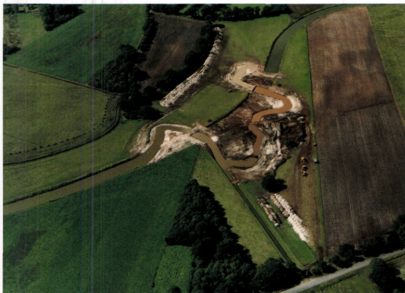
Fig. 7.1.2 De hermeandering van de Ruiten Aa in Westerwolde in uitvoering
