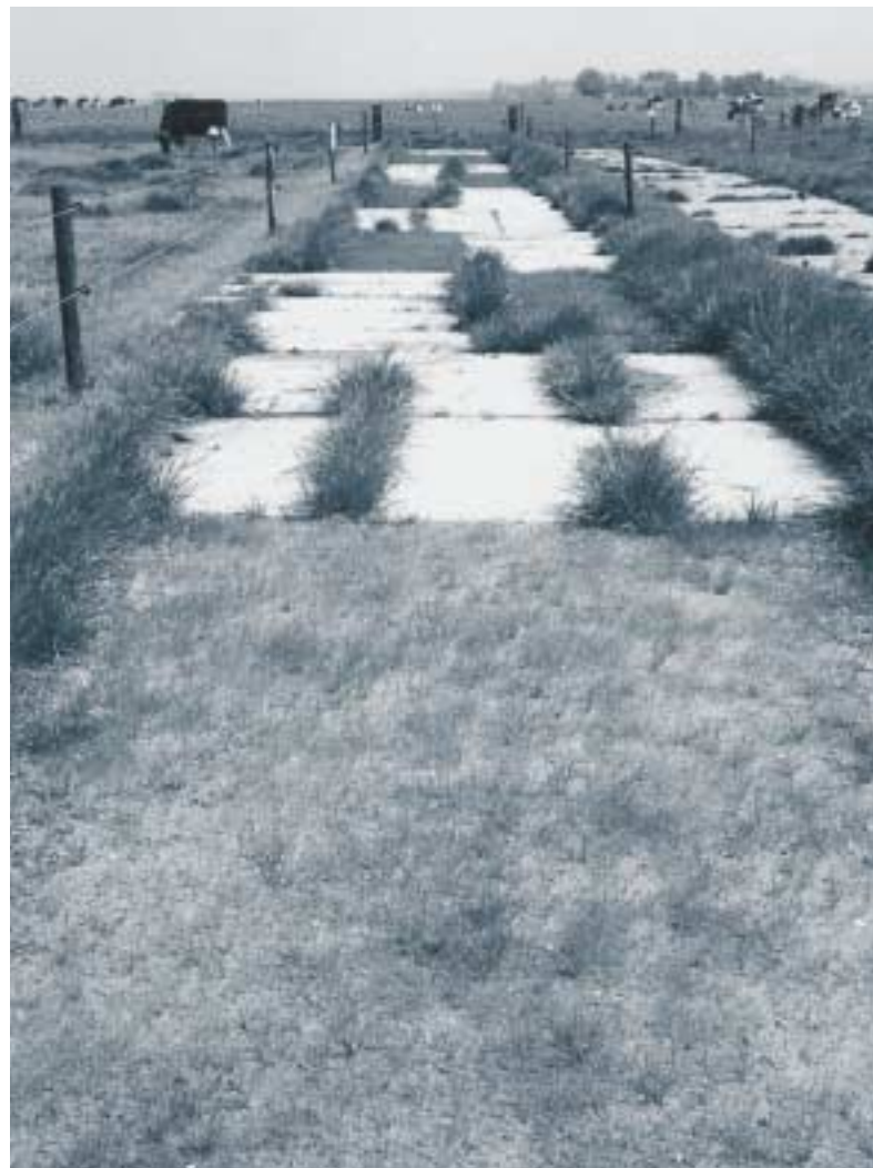
Kunststofgrasplaten (voorgond) in aanleg
