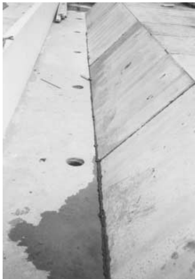
Prefab betonnen schuine kelderwanden tegen de ligvloer
