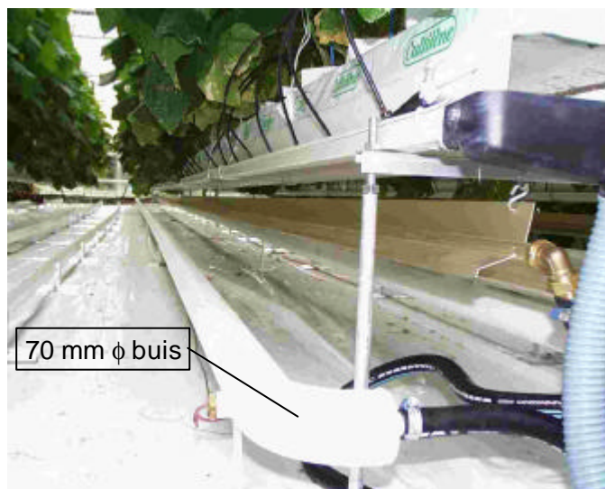
Figuur 4-4 Foto van de 70 mm buis onderin de kas.
