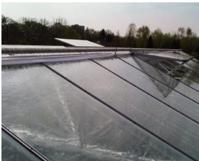
Figuur 4-8 Dakkoeling door middel van een koud-waterfilm op het kasdek (zie ook figuur 3-7). De waterfilm is goed te zien aan de rimpelingen op het kasdek.
