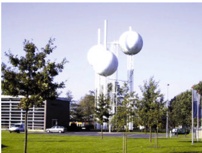
De watertoren van Eindhoven (architect Wim Quist; bouwjaar 1970)
