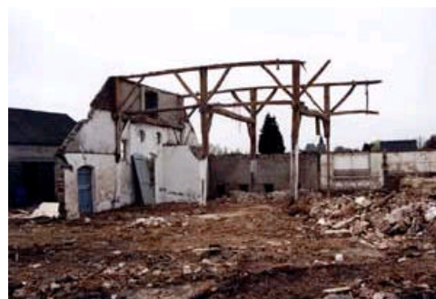
De boerderij afgebroken om later weer in oude stijl te worden opgebouwd
