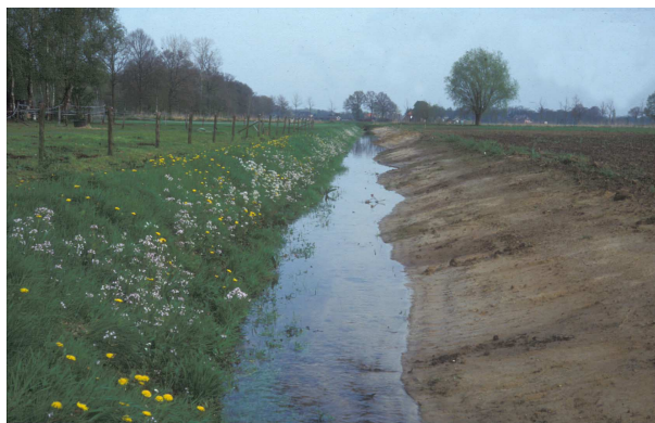
Foto 4.13: Resultaat van het herprofilen van het talud tot een flauwe oever van een watergang langs perceel 21, april 1998.
