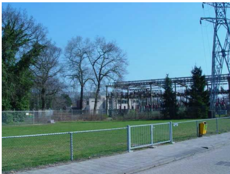
Figuur 1 het transformatorstation gezien vanaf de Knuttelweg
