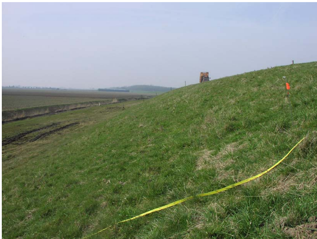
Foto 16. Dijkvak 40. Binnentalud maart 2003
