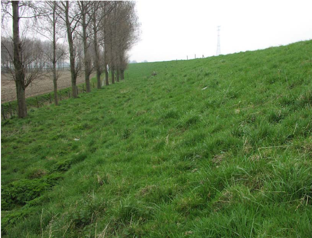
Foto 1. Dijkvak 5. Binnentalud, maart 2002
