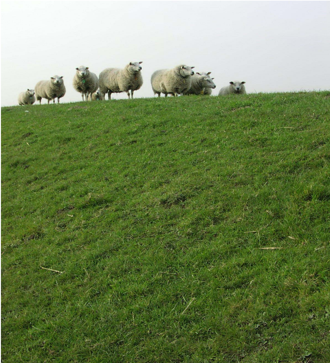
Foto 18. Dijkvak 42, Binnentalud maart 2002
