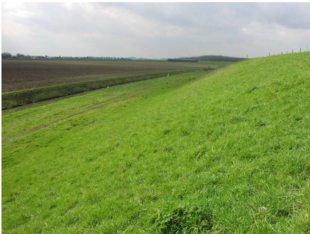
Foto 17. Dijkvak 40. Binnentalud maart 2004
