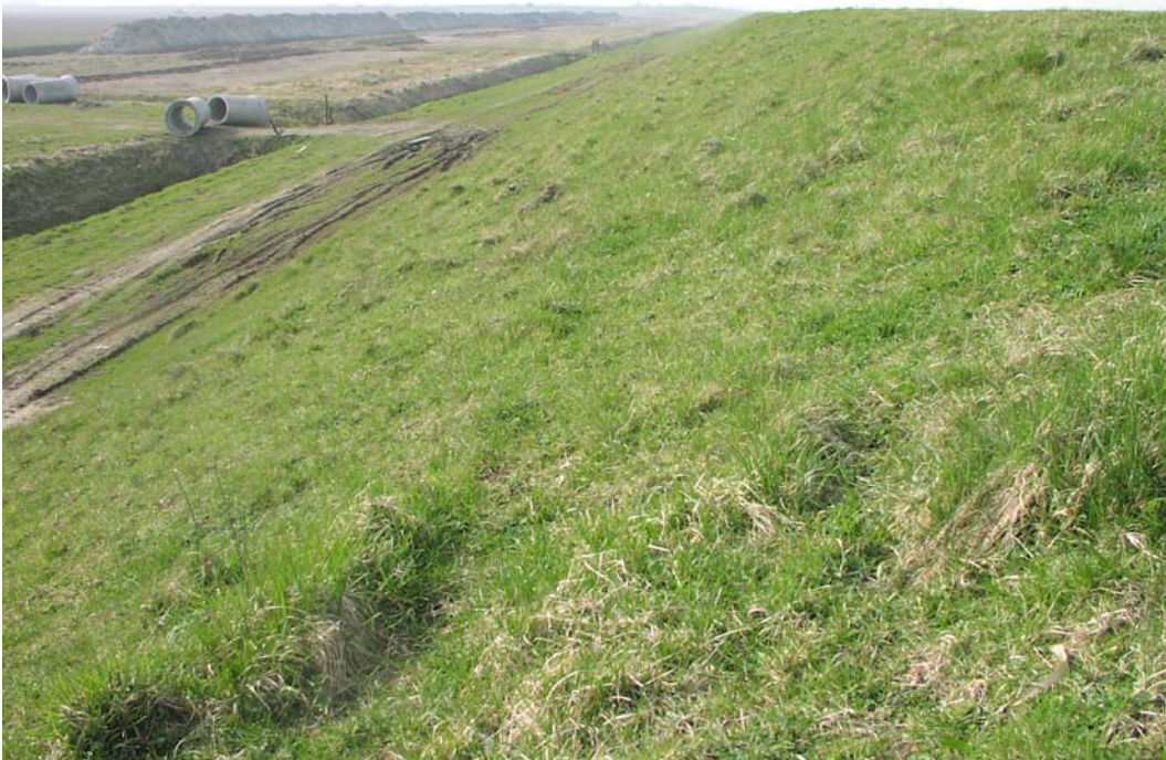
Foto 19. Dijkvak 42. Binnentalud maart 2003
