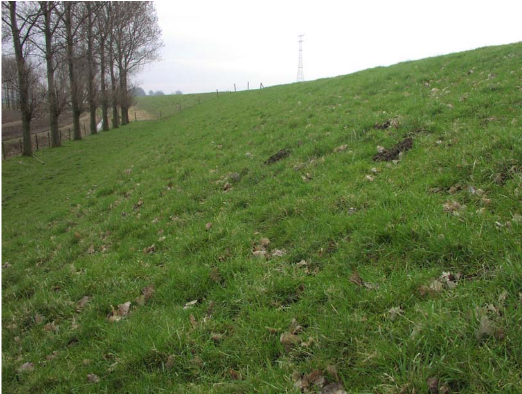
Foto 3. Dijkvak 5. Binnentalud, maart 2004
