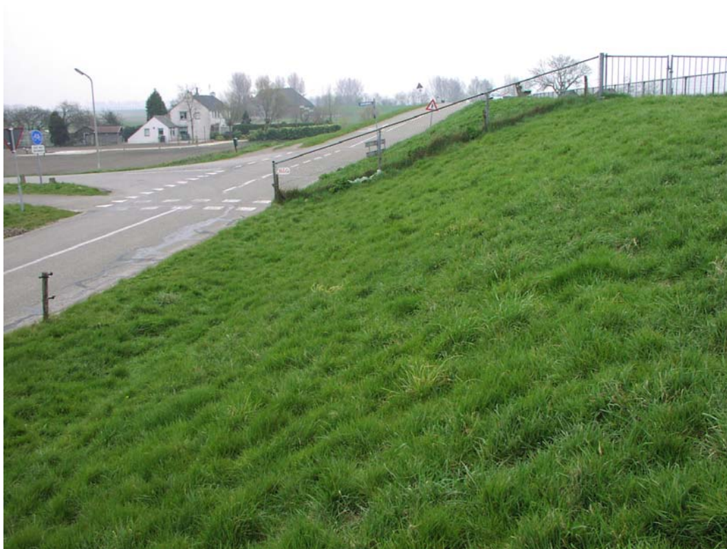
Foto 7 Dijkvak 6. Binnentalud maart 2002
