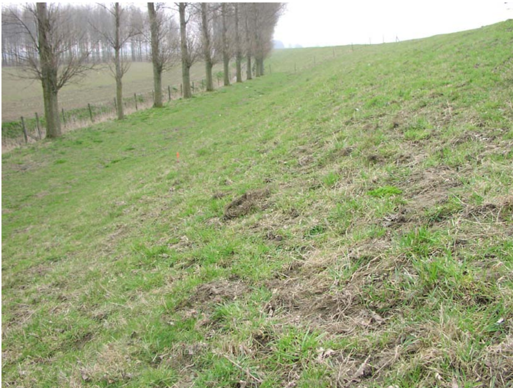
Foto 2. Dijkvak 5. Binnentalud, maart 2003
