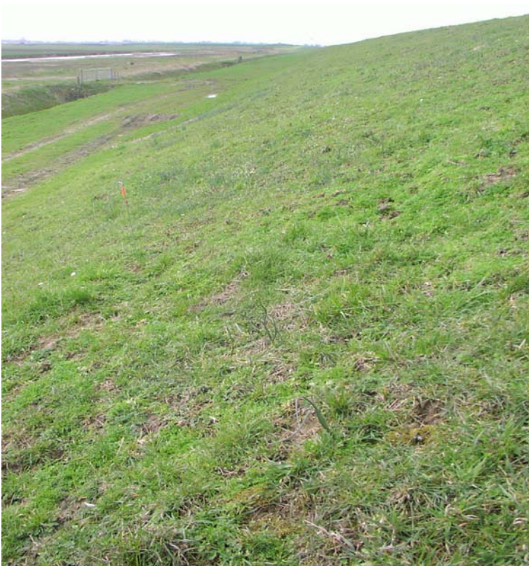
Foto 20. Dijkvak 42. Binnentalud maart 2004
