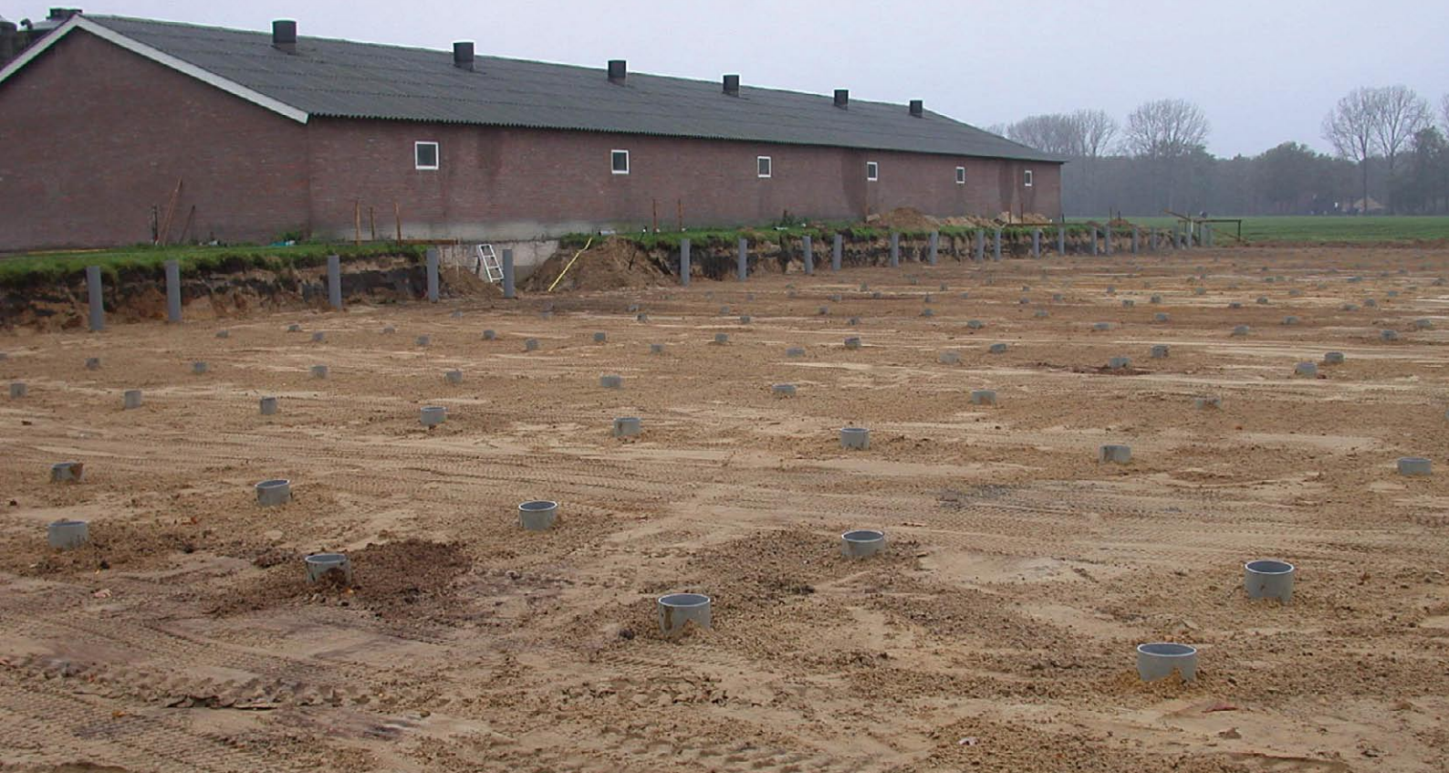
Het rioleringsysteem bij een Hercules stal in aanbouw
