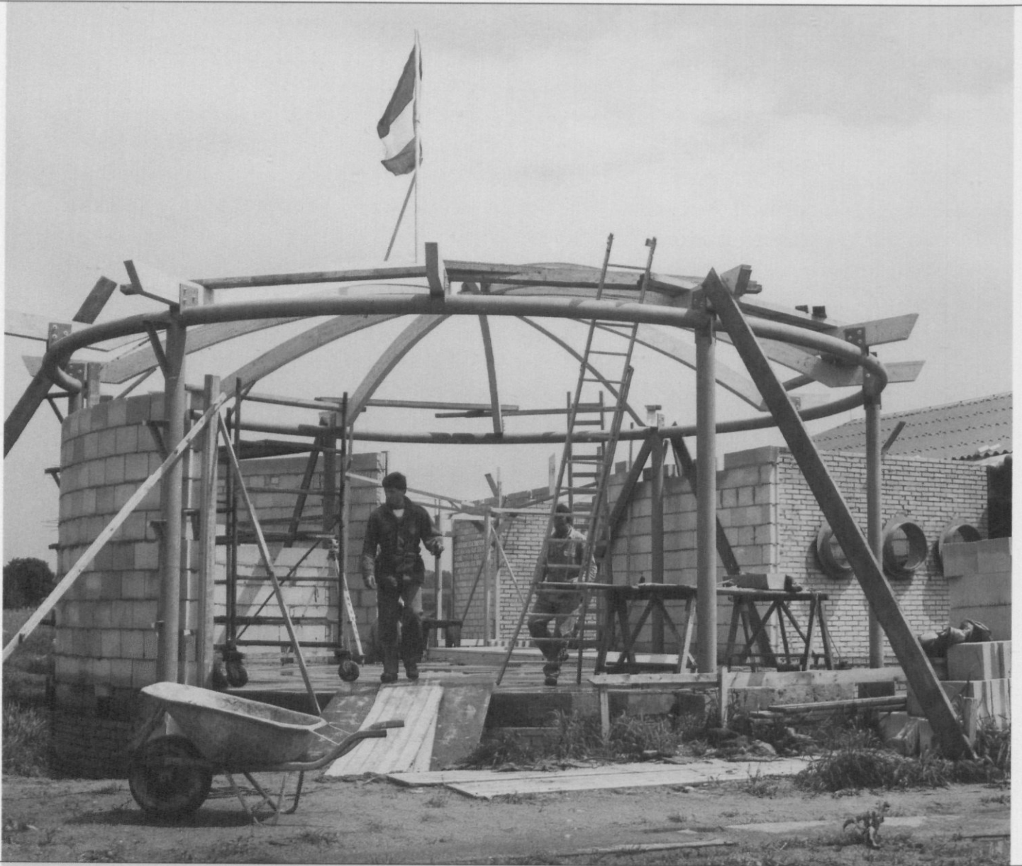
Bouw van de kantine van Proefhal Bennekom, 1987.
