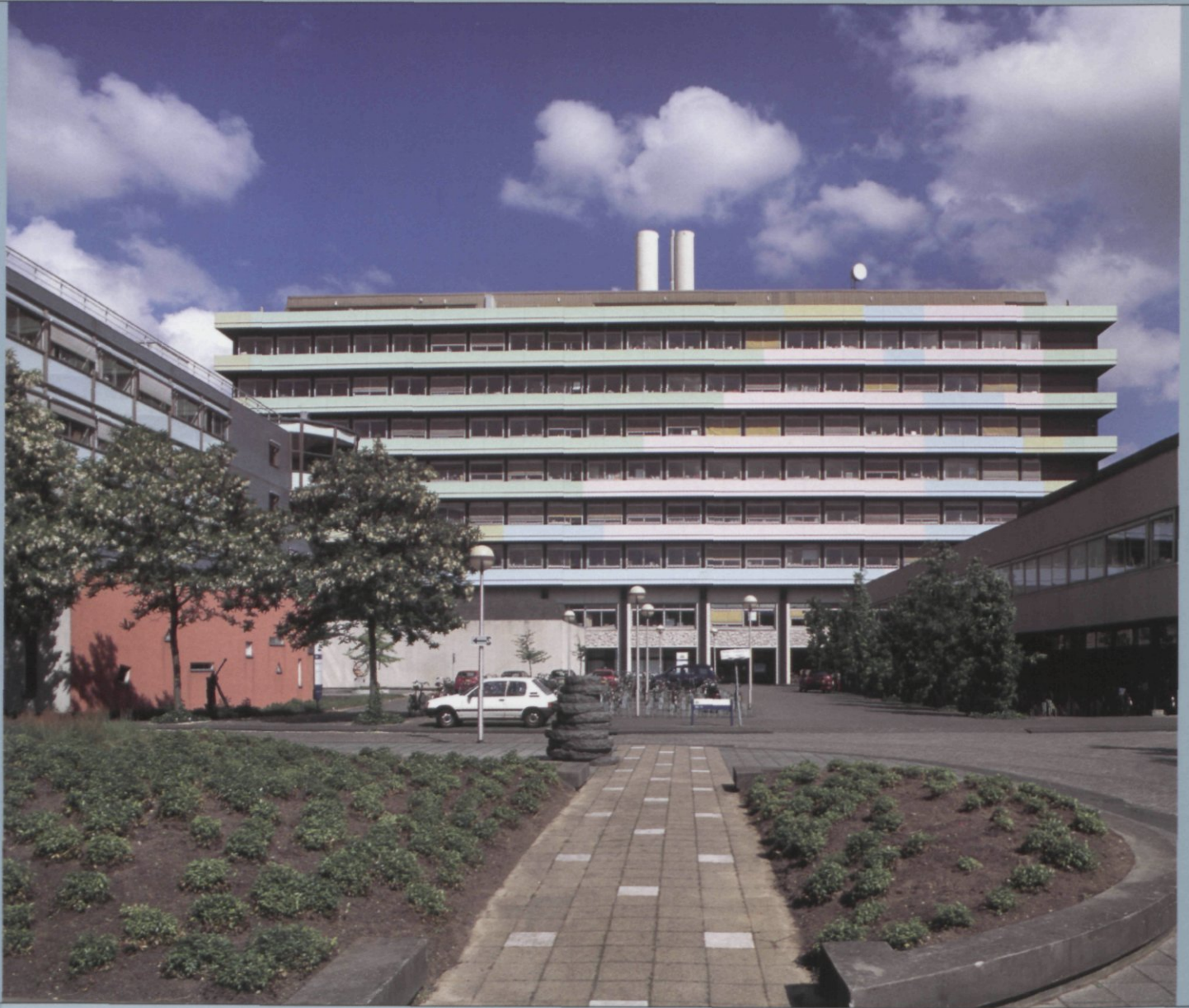
Biotechnion, met op de 7 e verdieping de sectie Milieutechnologie.
