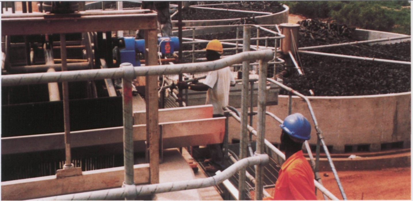
De bouw van een UASB-installatie voor een lokale gemeenschap in Accra, Ghana. Titia de Mes heeft ter plekke meegewerkt aan de opstart van deze reactor.
