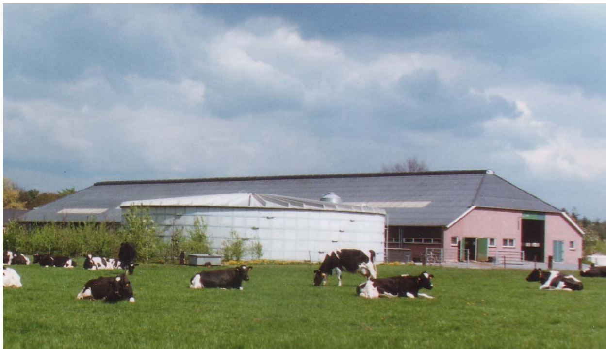
Het praktijkcentrum De Marke, met aan de zijkant van de stal de grote mestsilo
