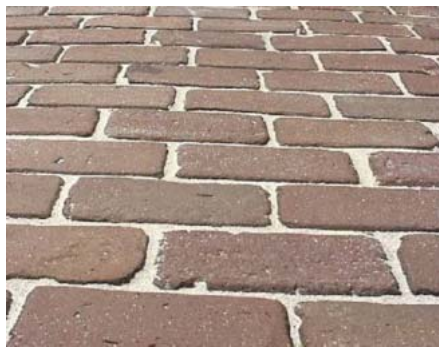
Afbeelding 4. Streetprotection voegvulling van Pressplate®. Foto: Pressplate® 2004.
