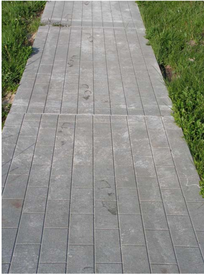
Betonplaten (EV), één jaar na aanleg.
