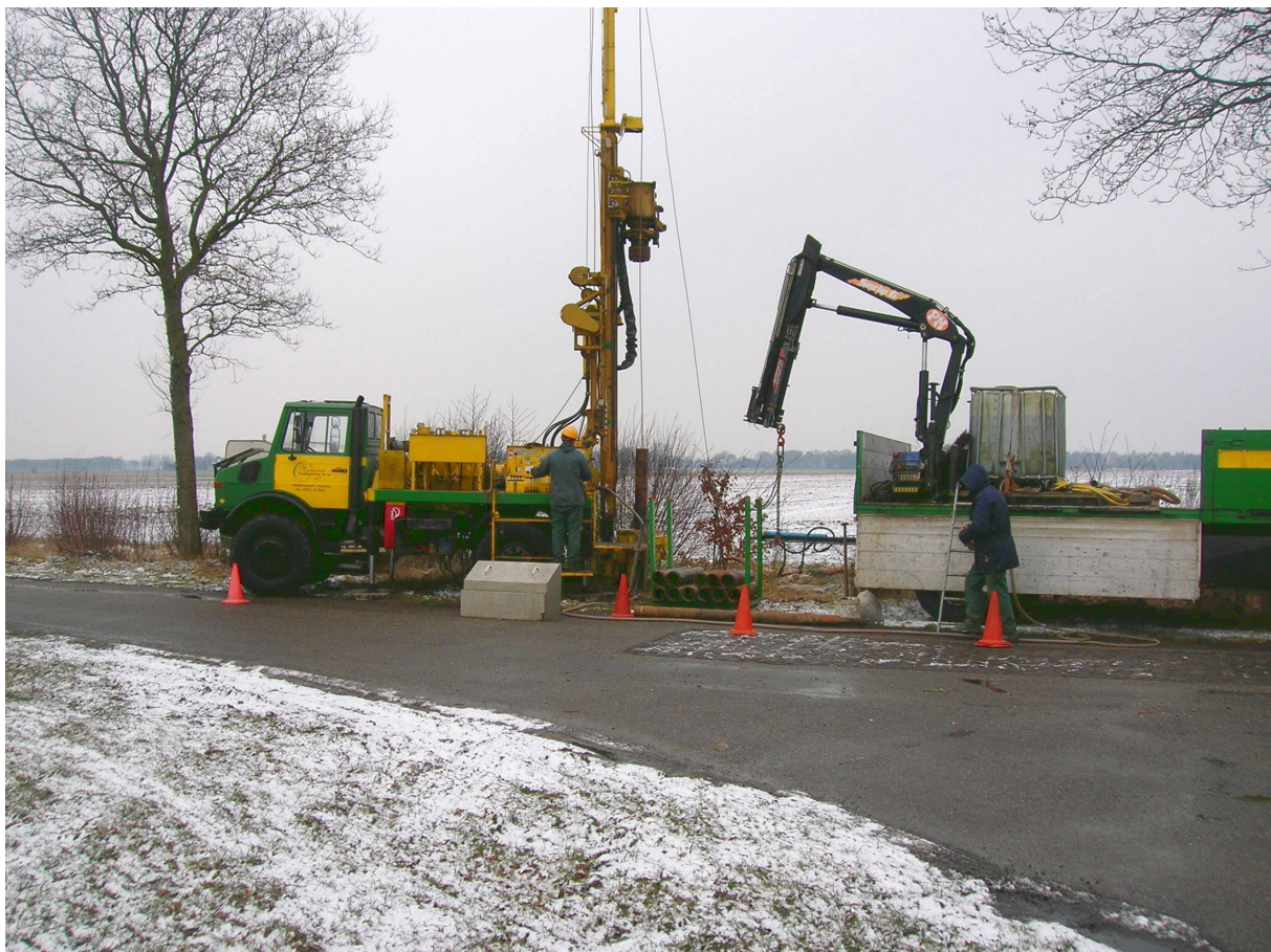
Foto 1 Opstelling pulsboorinstallatie voor diepboringen
