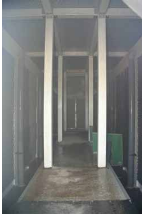
Binnenkant van de wasser: de opening tussen de twee units en de opening waardoor de stallucht de wasser in gaat
