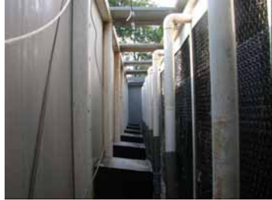
Chemische wasser achter de vleeskuikensouderdierenstal en de uitstroomopening van de uitgaande gewassen lucht
