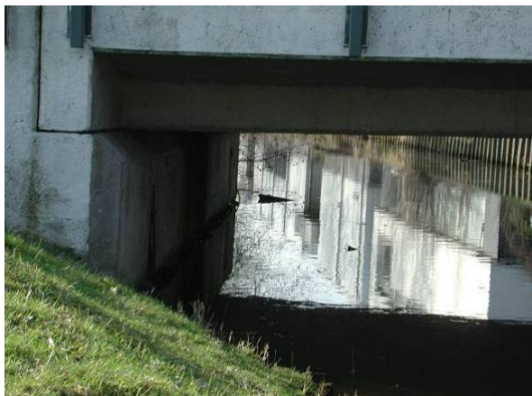
Beeld in mrt 2005, voor aanleg faunapassages
