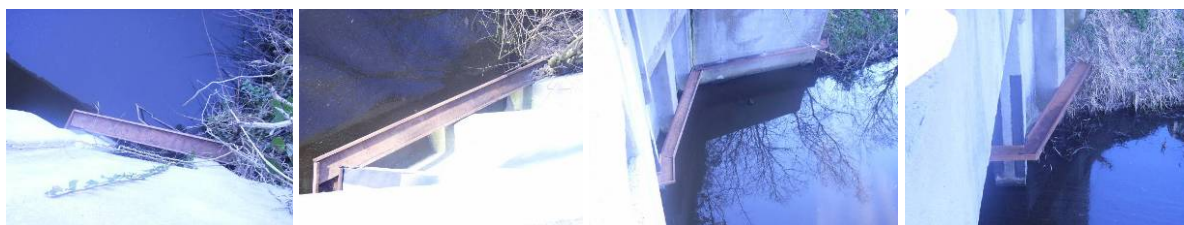
Bovenaanzicht aansluiting faunapassage bij PPO, Ruiten, Elout en Geerlings brug Achterweg in mrt 2007
