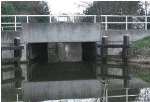
Beeld in mrt 2005, voor aanleg faunapassages
