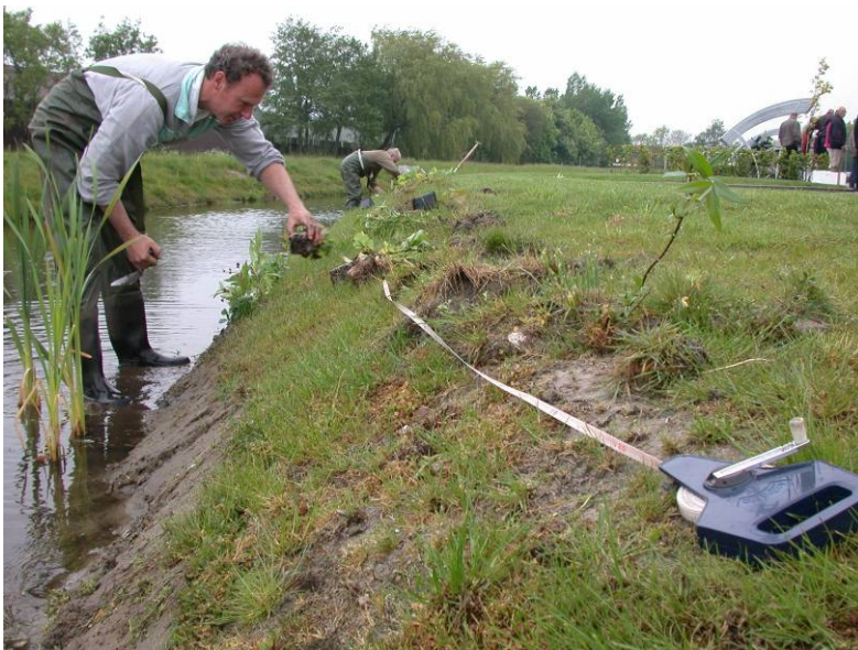
Aanleg oeverbeplanting in 2005
