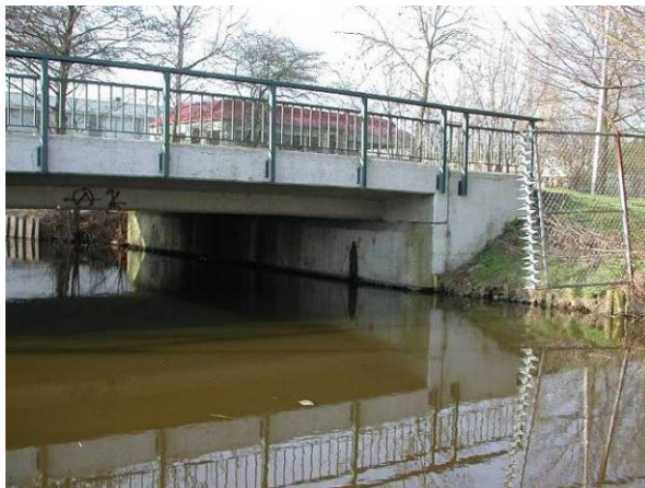
Beeld in mrt 2005, voor aanleg faunapassages
