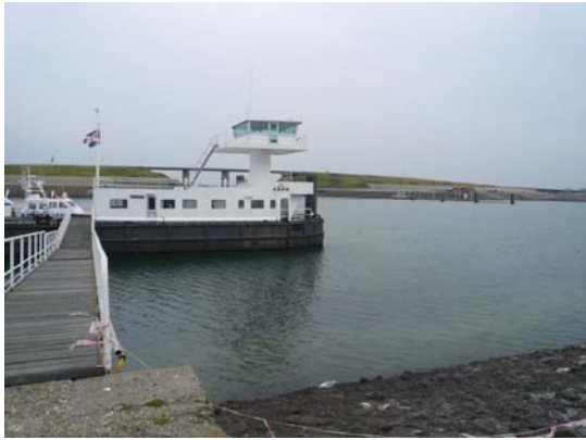
Figuur 40. Locatie van de kooi aan het ponton van de reddingsboot bij de stormvloedkering.
