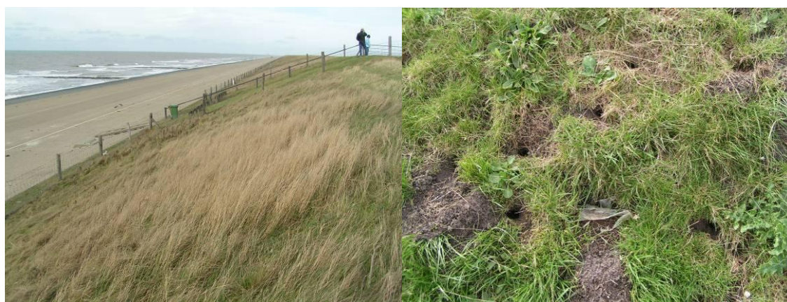
Afbeelding 3.5. en 3.6. Hondsbossche Zeewering. Links: ongemaaide vegetatie met geringe erosiebestendigheid; rechts: onbegraasd binnentalud met muizenholletjes (foto's Joep Frissel).
