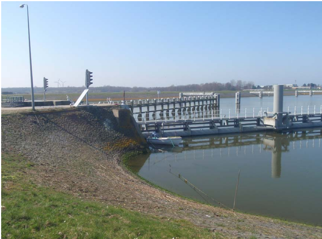
Plaatsen van de lichtvallen in Den Oever. (Foto: Jan van der Heul)
