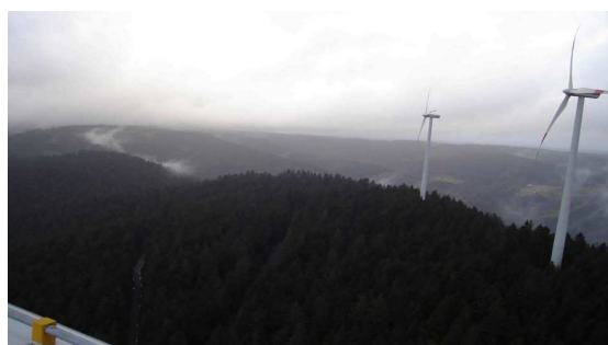
Windturbines in dichte bebossing (Zweden)
