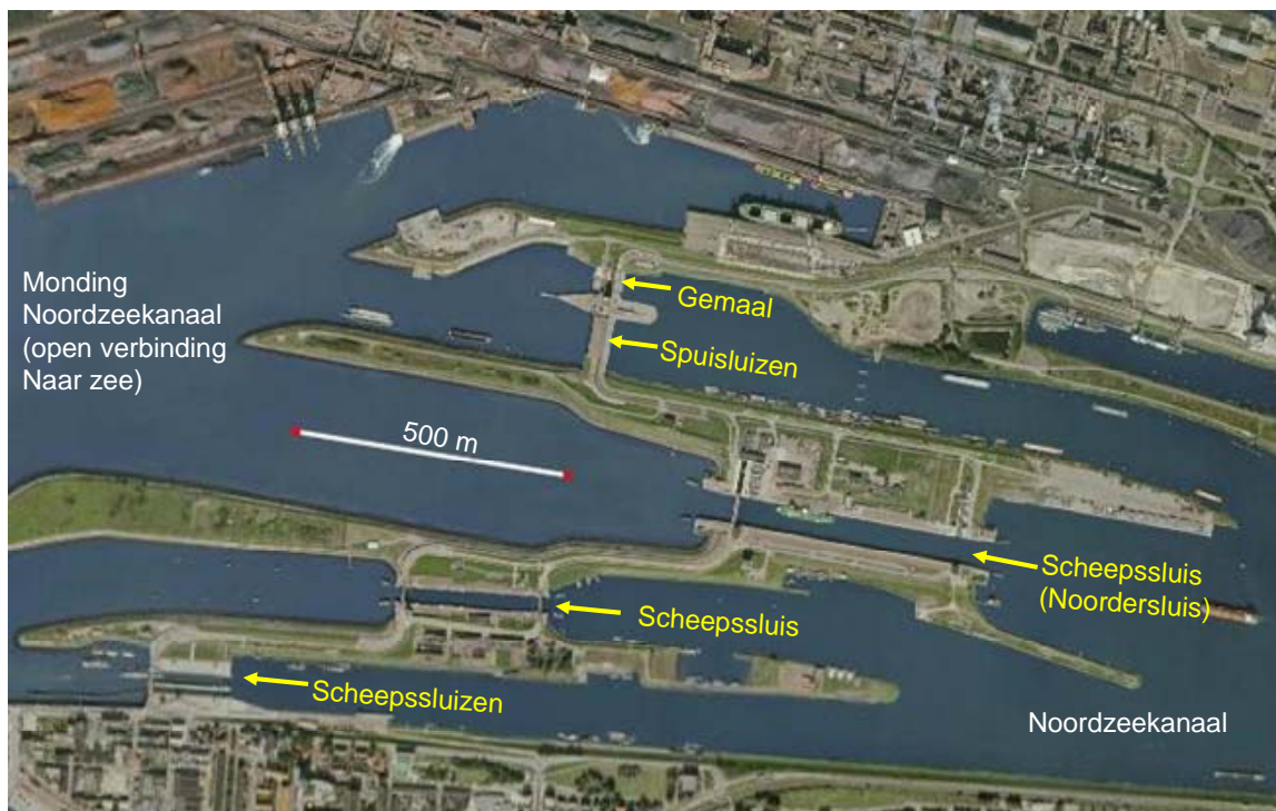
Figuur 24. Overzicht van het sluisencomplex in het Noordzeekanaal bij IJmuiden.
