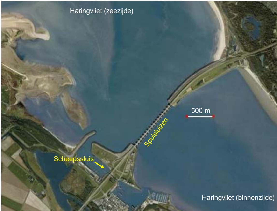
Figuur 27. Overzicht van de Haringvlietdam
