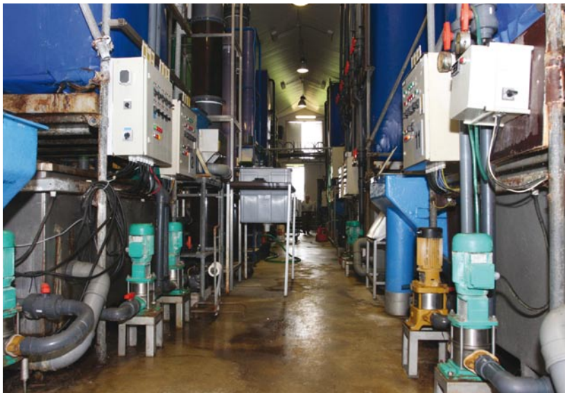
De centrale hal is het zenuwcentrum van waaruit de watertoevoer naar de aquaria en kweekbakken wordt gereguleerd.
