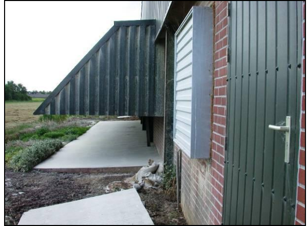
Luchtuitleet in achtergevel
