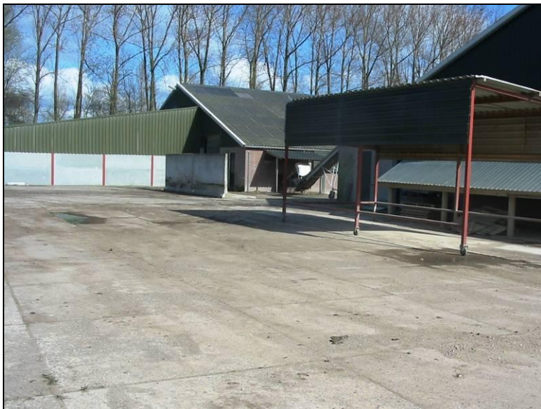
Achtergevel met luchtuitleet (linker stal)
