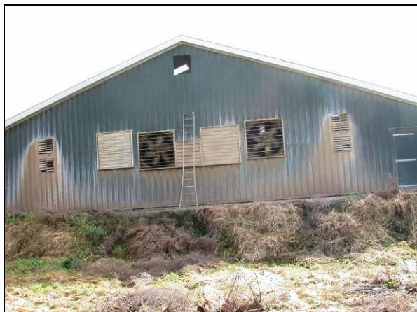
Achtergevel stal, met ventilatoren voor de uitgaande lucht
