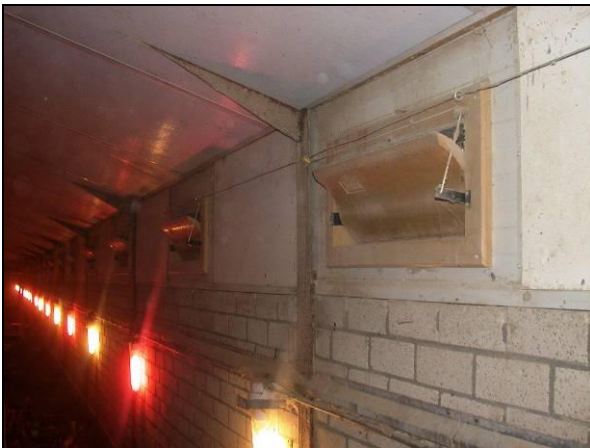
Binnenzijde inlaatventielen in zijgevel
