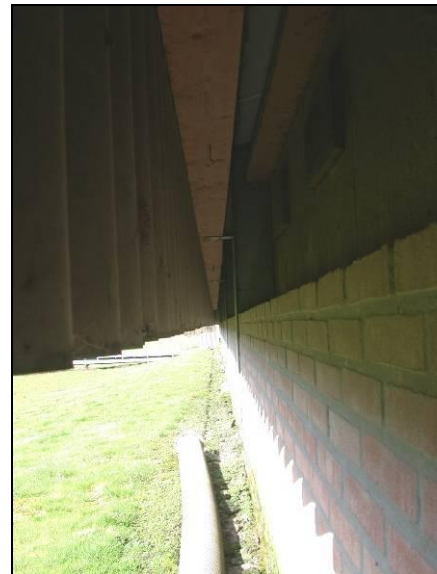
Detailfoto luchtinlaat buitenzijde
