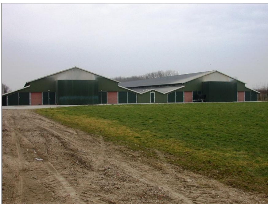
Overzicht van de stallen (achtergevels met luchtuitlaat)
