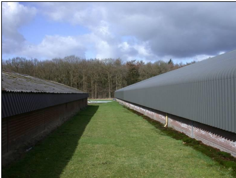
Luchtinlaat (winddrukcap, stal rechts)
