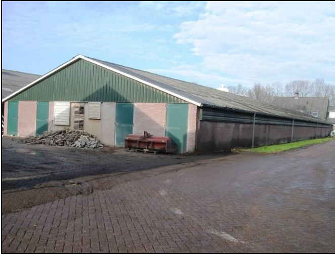
Achtergevel stal, met ventilatoren (uitgaande lucht)
