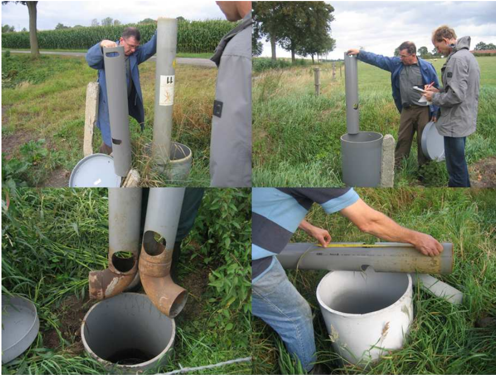
Fotocollage 42 Bezoek aan agrariërs - impressie PVC instelpijpen (1) – agrariërs tonen diverse instelpijpen; de ronde gaten, aangebracht aan de onderzijde bepalen het maximum waterpeil in de putten, en daarmee de intensiteit van de drainage in het ‘aangekoppelde’ perceel.
