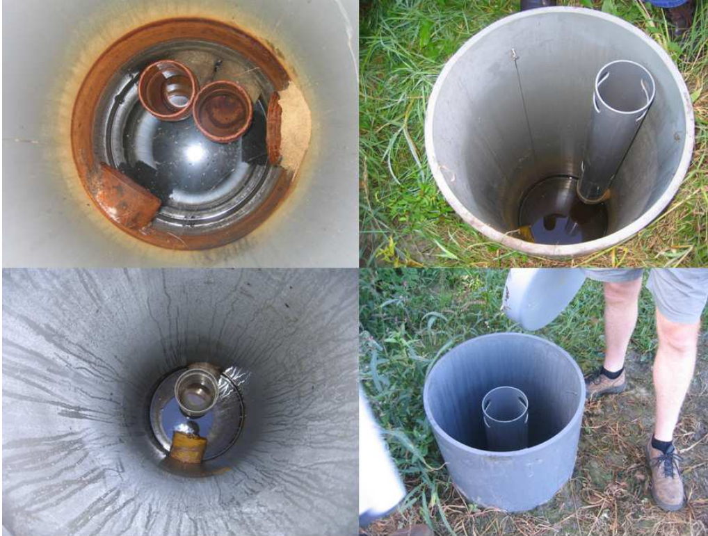
Fotocollage 40 Bezoek aan agrariërs - impressie putten inwendig (5) – linksboven: twee uitmondende verzameldrains en twee afvoerbuizen; deze put heeft last van ijzerneslagen; op de overige foto's diverse voorbeelden van enkelvoudige putten.
