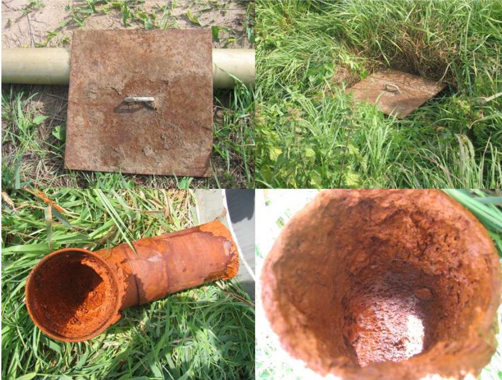
Fotocollage 44 Bezoek aan agrariërs - impressie PVC instelpijpen (3) – bovenin een metalen putdeksel (zeldzaam; tot nu toe slechts één keer aangetroffen) en een voorbeeld van ijzerafzettingen die zó sterk zijn, dat de werking van het onderhavige drainagesysteem wellicht in het geding is.
