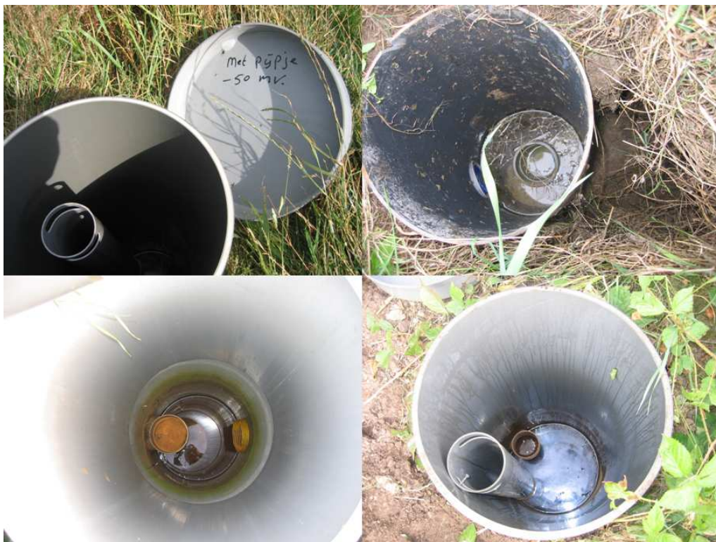
Fotocollage 37 Bezoek aan agrariërs - impressie putten inwendig (2) – onderin elke put zien we steeds hetzelfde patroon: de uitmonding van een (doorgaans geel gekleurde) verzameldrain, en een omhoog gerichte afvoerbuis, waarop een extra PVC regelbuis geplaatst kan worden; deze regelbuis is voorzien van zijdelingse openingen op de hoogte van de gewenste ontwateringsdiepte (hier niet goed zichtbaar), en twee handgrepen bovenin, in de vorm van uitsparingen.
