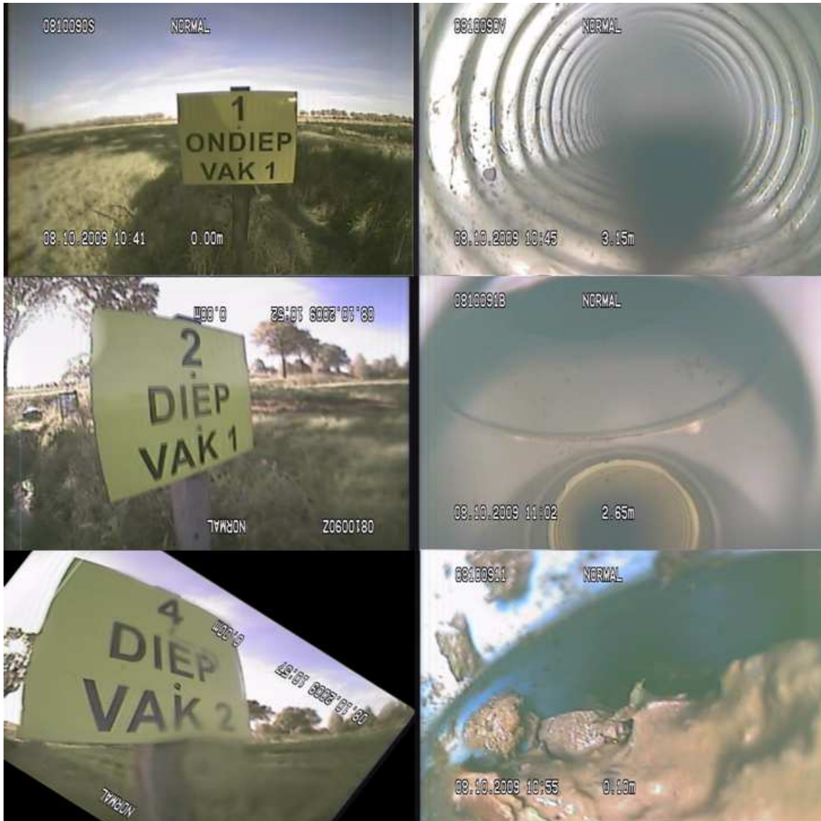
Fotocollage 16 Inwendige inspectie van draineerbuizen: drain 1: ondiep geïnstalleerde drain, watervoerend en betrekkelijk schoon (3,15m vanaf uitstroomopening in slootwand), want nog nauwelijks waterafvoerend geweest; drain 2: diep geïnstalleerde drain, koppelstuk met verzamel drain ('collectordrain') op 2,65m vanaf uitstroomopening in slootwand; drain 4: diep geïnstalleerde drain, ophoping van bodemmateriaal in blauwe eindbuis, 10cm vanaf uitstroomopening in slootwand, waardoor verdere inspectie onmogelijk is.
