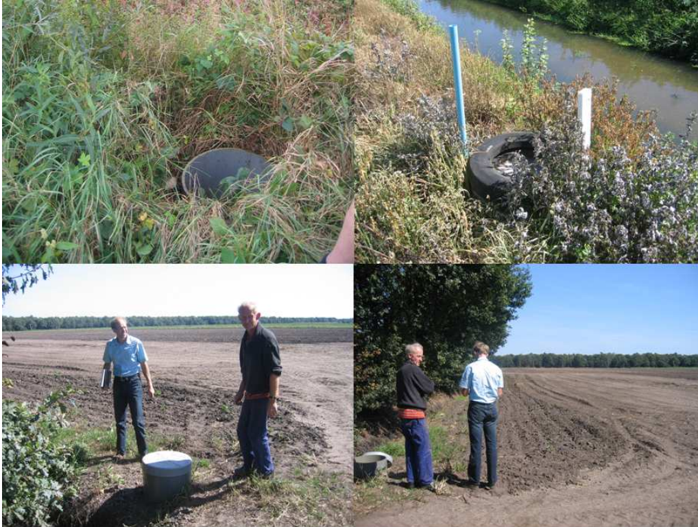
Fotocollage 35 Bezoek aan agrariërs - impressie putten aan perceelsranden (5) – een ‘verdwenen’ put herontdekt (linksboven); een put die gemarkeerd wordt met een autoband (rechtsboven); twee putten van een agrariër die aanvankelijk weinig heil zag in het systeem, maar gaandeweg steeds positiever over deze vorm van draineren c.q. ondergronds infiltreren is gaan denken.
