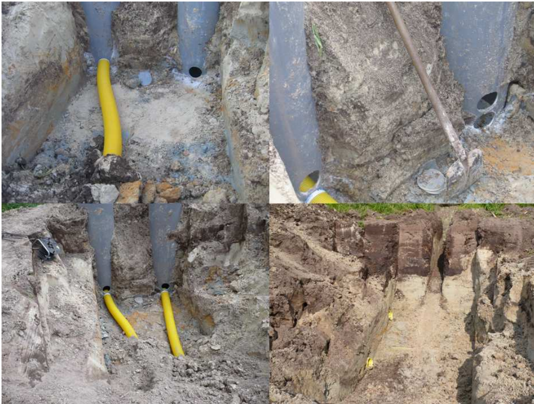
Fotocollage 4 Impressies van de installatie van het experimentele samengestelde, peilgestuurde drainagesysteem op proefperceel Ospel (3). Van linksboven naar rechtsonder, achtereenvolgens: (i) aansluiting van collectorbuis op meetput fase 1, (ii) nieuwe gaten geboord na foutieve hoogtemeting door de draineur, (iii) aansluiting van collectorbuis op meetput fase 2 en (iv) kapotgetrokken, foutief geïnstalleerde reeksen collectorbuizen
