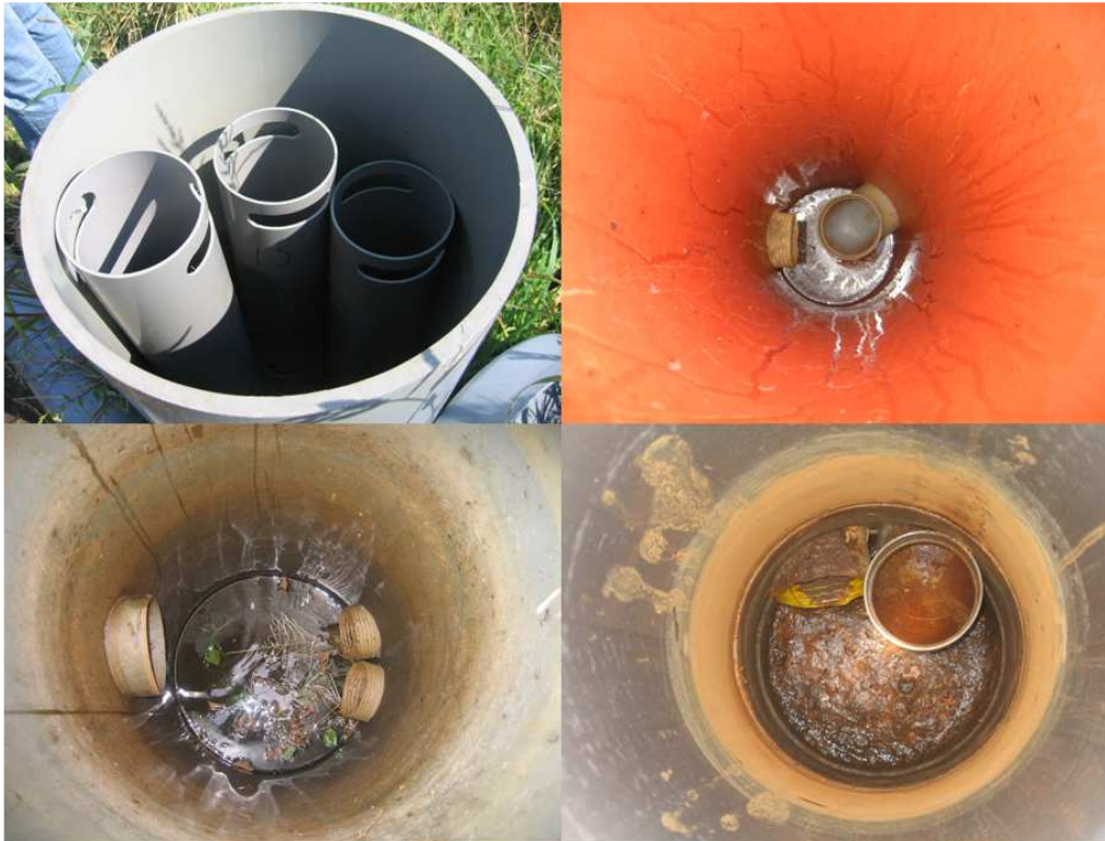
Fotocollage 39 Bezoek aan agrariërs - impressie putten inwendig (4) – linksboven een voorbeeld van een complexe put waarin water via afzonderlijke verticale uitstroombuizen naar drie bestemmingen wordt herverdeeld; deze bestemmingen kunnen nabijgelegen percelen zijn, maar bijvoorbeeld ook een nabijgelegen perceelssloot; rechtsboven een voorbeeld van een oranje 'eerste generatie' verzamelput met betrekkelijk kleine diameter; linksonder een voorbeeld van een verzamelput waarin twee verzameldrains uitmonden; in het water zweven plantenresten; rechtsonder een put met ijzrneerslagen en sediment.
