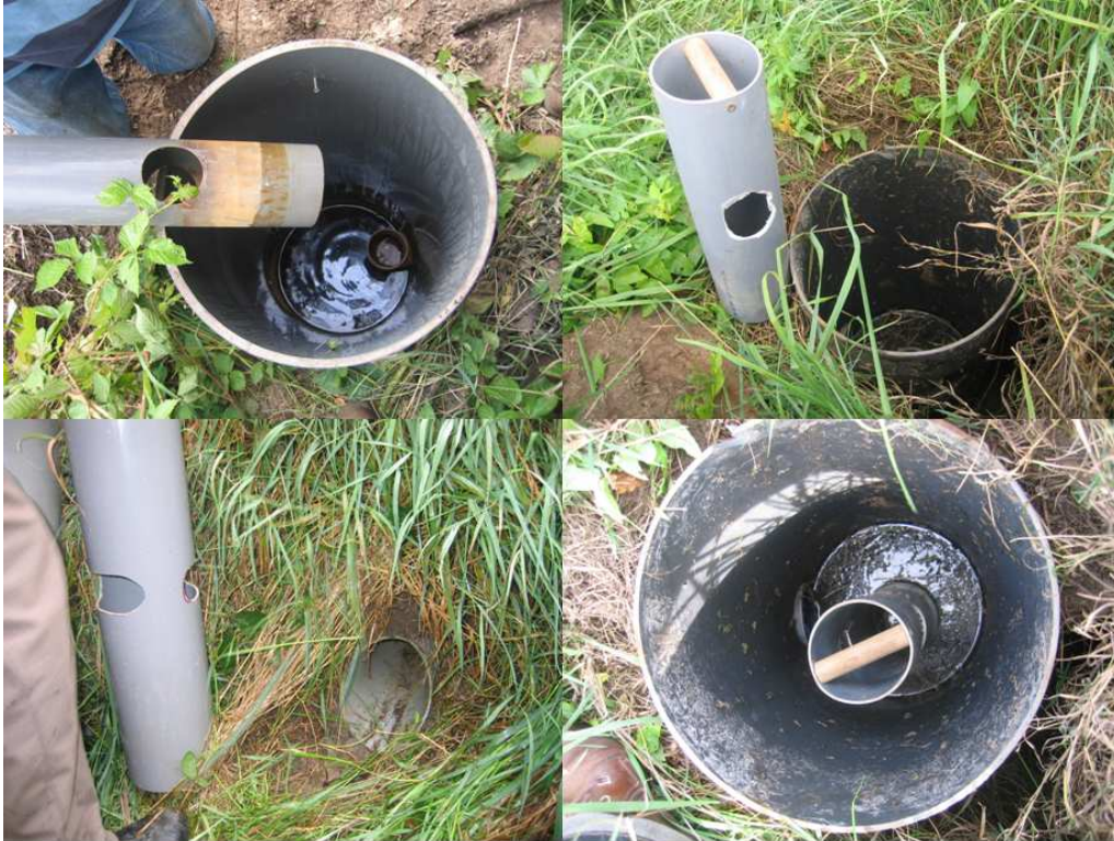
Fotocollage 43 Bezoek aan agrariërs - impressie PVC instelpijpen (2) – diverse vormen van instelpijpen; inmiddels zijn meerdere configuraties geleverd; de versie met een houten handgreep is zeldzaam; soms wordt slordig gewerkt (rechtsboven); reden waarom gestreefd moet worden naar standaardisatie (bijvoorbeeld KOMO-Keur) van Samengestelde, Peilgestuurde drainagesystemen.
