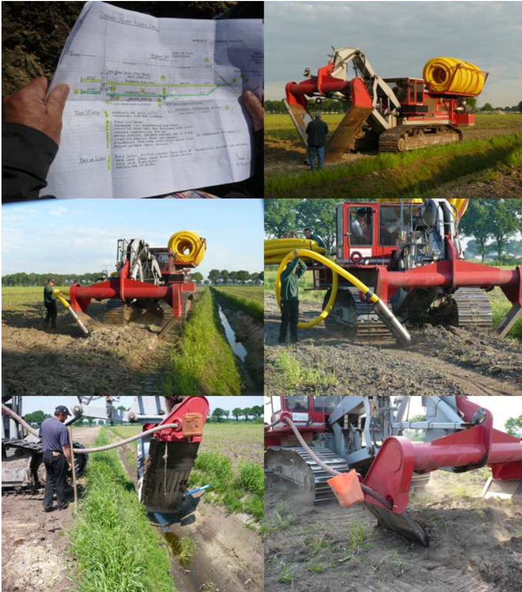
Fotocollage 2 Impressies van de installatie van het experimentele samengestelde, peilgestuurde drainagesysteem op proefperceel Ospel (1). Van linksboven naar rechtsonder achter-eenvolgens: (i) bestektekening, (ii) draineermachine met sleufloze 'Delta'-ploeg, (iii) installatie van de eerste collectorbuis, (iv) invoer van collectorbuis in de ploeg, (v) positionering van 'Delta'-ploeg aan sloodtalud bij begin van installatie van draineerbuis en (vi) sleufloze installatie van draineerbuis.
