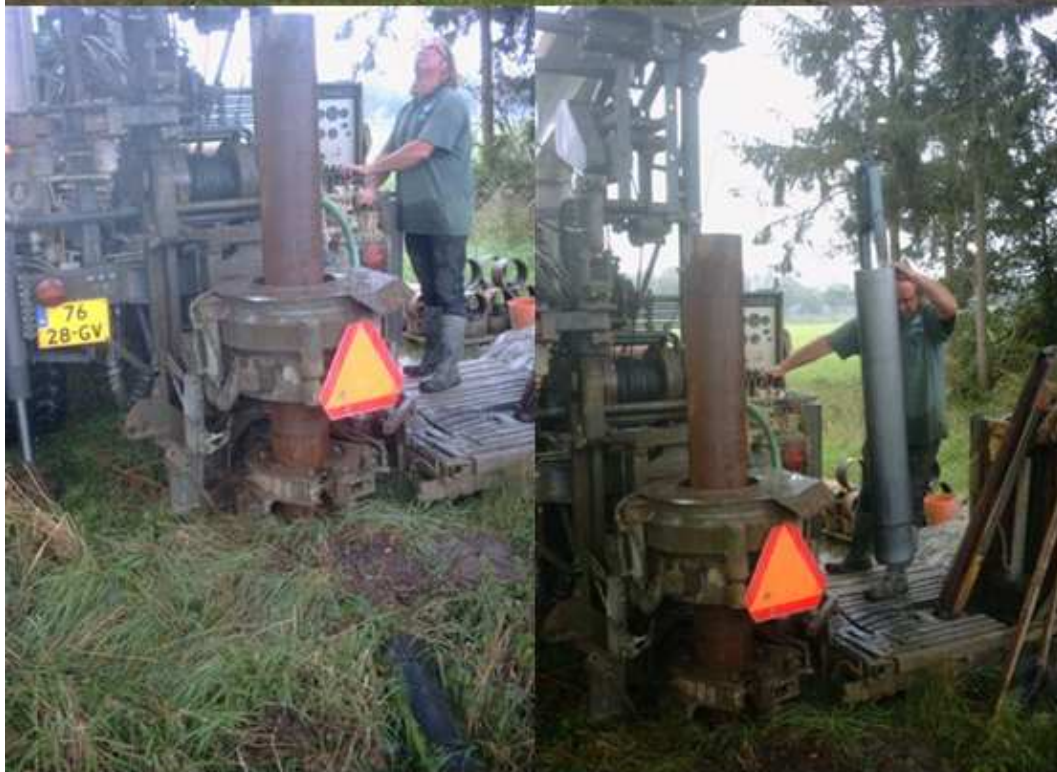
Fotocollage 26 Aanbrengen beregeningsput bij proeflocatie Ospel (1)
