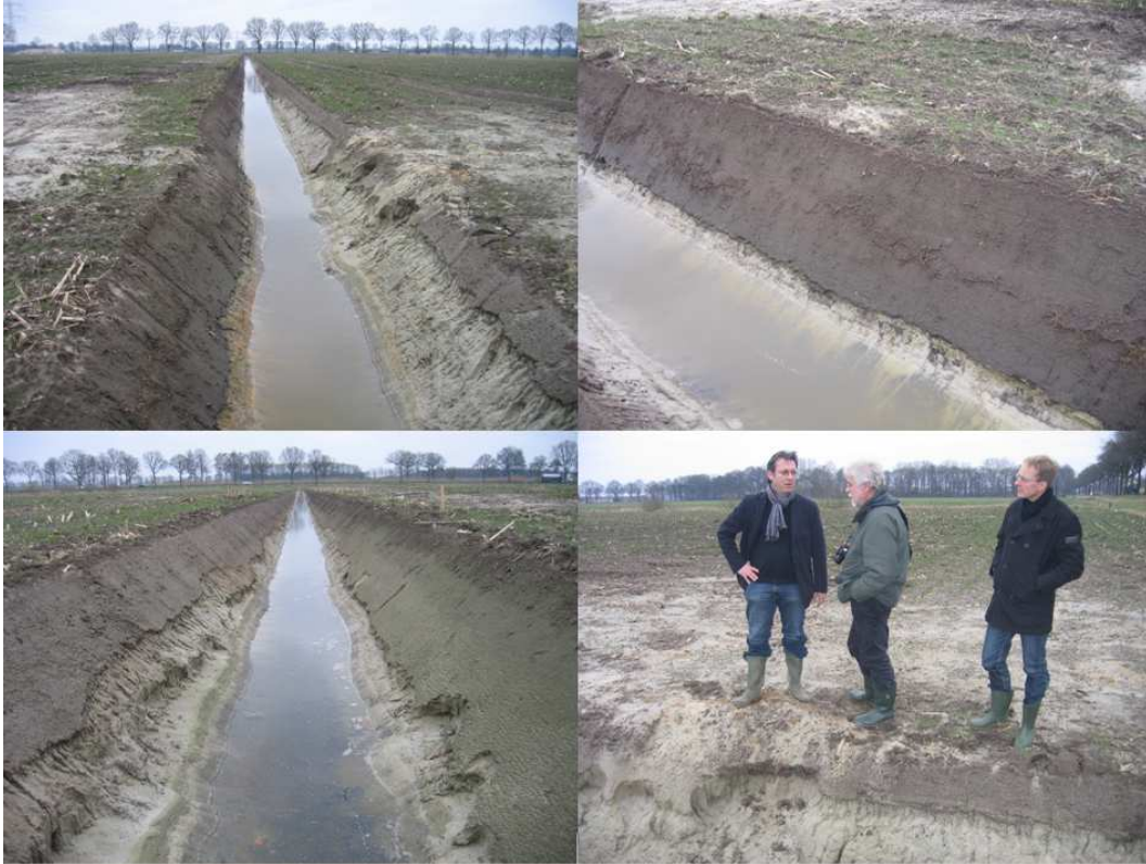
Fotocollage 1 De zojuist gegraven perceelsloot wordt geïnspecteerd door Jacques Peerboom (Waterschap Peel en Maasvallei), Jan van Bakel (WUR) en Wim van Dijk (WUR)
