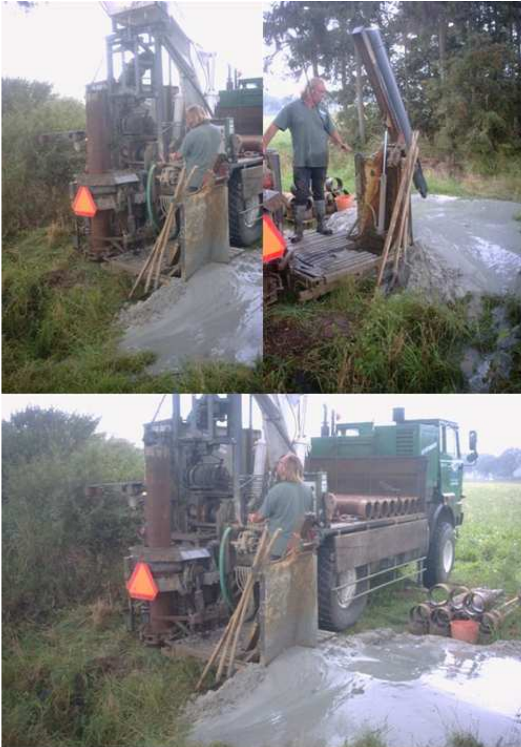
Fotocollage 27 Aanbrengen beregeningsput bij proeflocatie Ospel (2)
