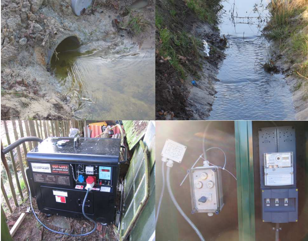
Fotocollage 11 Van linksboven naar rechtsonder, achtereenvolgens: (i) door de ingeschakelde pomp komt de waterafvoer op gang, (ii) de pomp heeft een enorme capaciteit, waardoor de sloot snel wordt 'leeggetrokken', (iii) het dieselaggregaat (draaistroom), (iv) elektrische installatie van de aansluiting op het elektriciteitsnet (nog niet geheel gereed).
