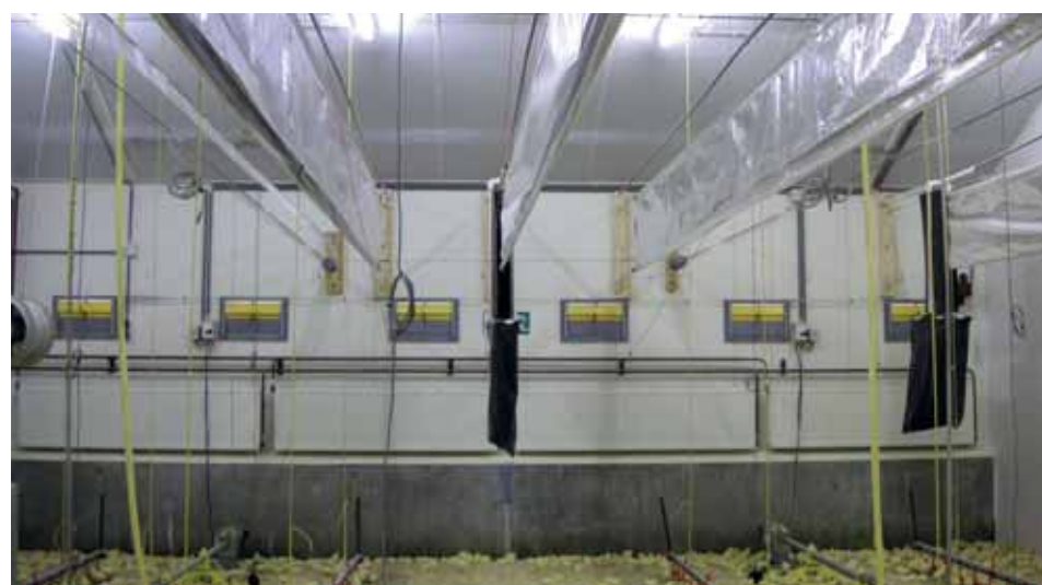
Boven: het ionisatiesysteem in de eerste onderzoeksrunde. Onder: het ionisatiesysteem in de tweede ronde, uitgerust met een halfautomatisch schoonmaaksysteem
