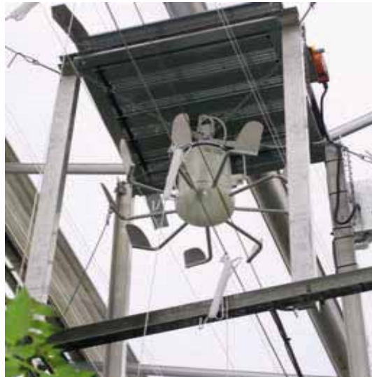
Foto 2. Aircobreeze met daarboven het diafragma: regelbare lamellen die passen op een gat in het schermdoek. Ventilatorsnelheid en diafragmastand regelen de hoeveelheid lucht die wordt aangezogen van boven het scherm. (a) close-up en (b) plaatsing in de kas.
