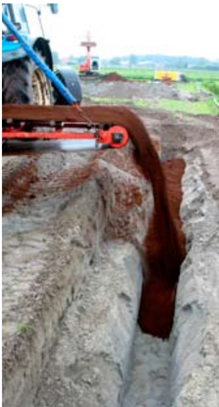
Aanleg van de proef om in bodem- en slotwater het fosfaatgehalte te verlagen
