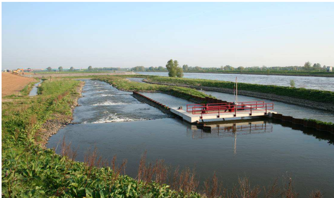
Vistrap bij Hagestein met 'dubbele' instroomopening i.v.m. variaties in bovenstroomse waterstanden
