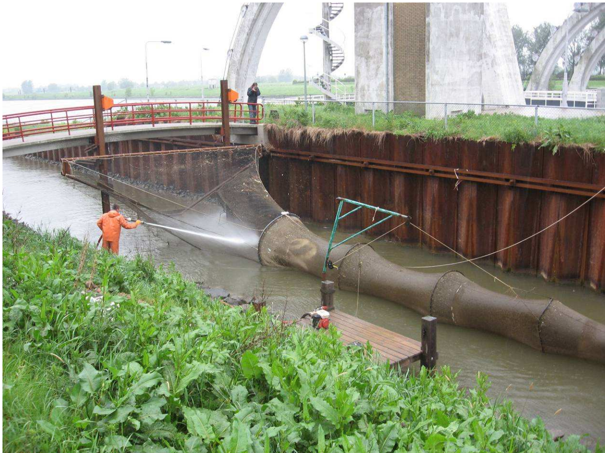
Het lichten en schoonspuiten van de fuik in de vistrap bij Hagestein. De V-vormige opening is geheven.
