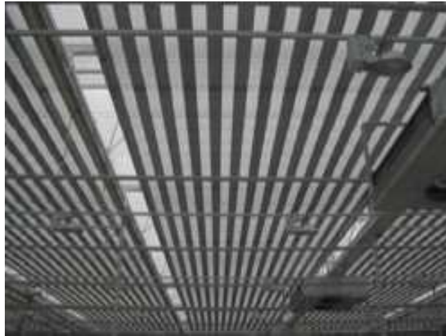
Figuur 2. Een diafragmascherm in de 45% schaduwstand.
