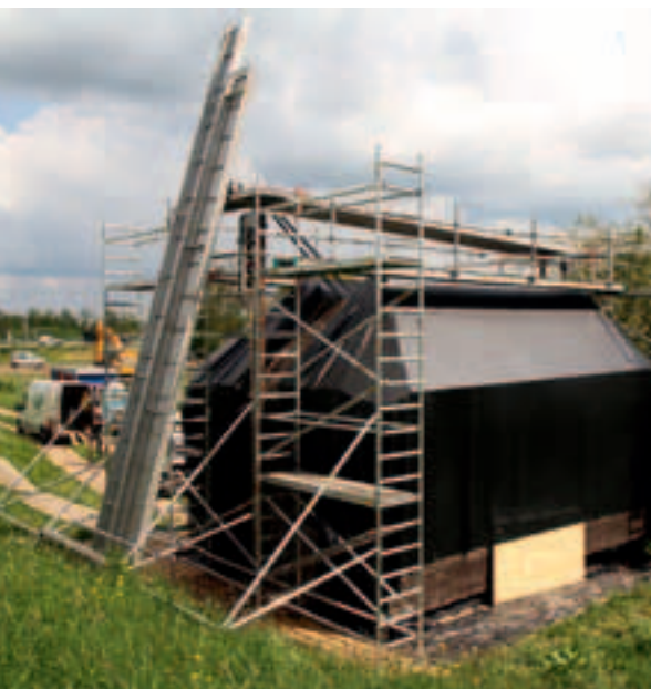
Bunker aan de Diefdijk wordt doorgezaagd zodat aan de buitenkant te zien is, hoe het er van binnen uitziet.
