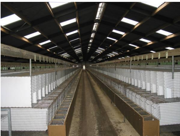
Nertsenstal met kooien, de houten bakjes voor de kooien zijn nesten. Bovenin de stal is de luchtuitlaat zichtbaar
