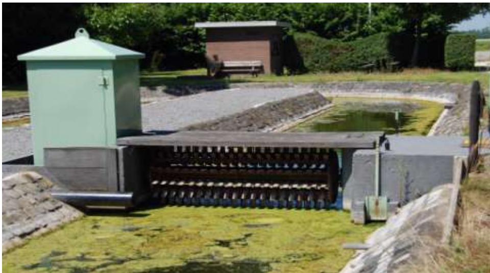
Figuur 4 Pasveersloot voor biologische zuivering van huishoudelijk afvalwater. Het schoepenwiel zorgt voor zuurstofinbreng en een rondgaande beweging van het afvalwater. De Pasveersloot was een voorloper van de huidige rioolwaterzuiveringen met bellenbeluchting.
