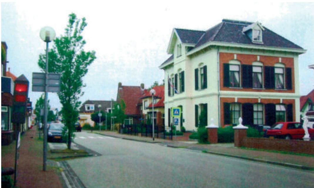
Het voormalige gerechtsgebouw in Zuidbroek is door dorpsbewoners behouden voor de sloop.
