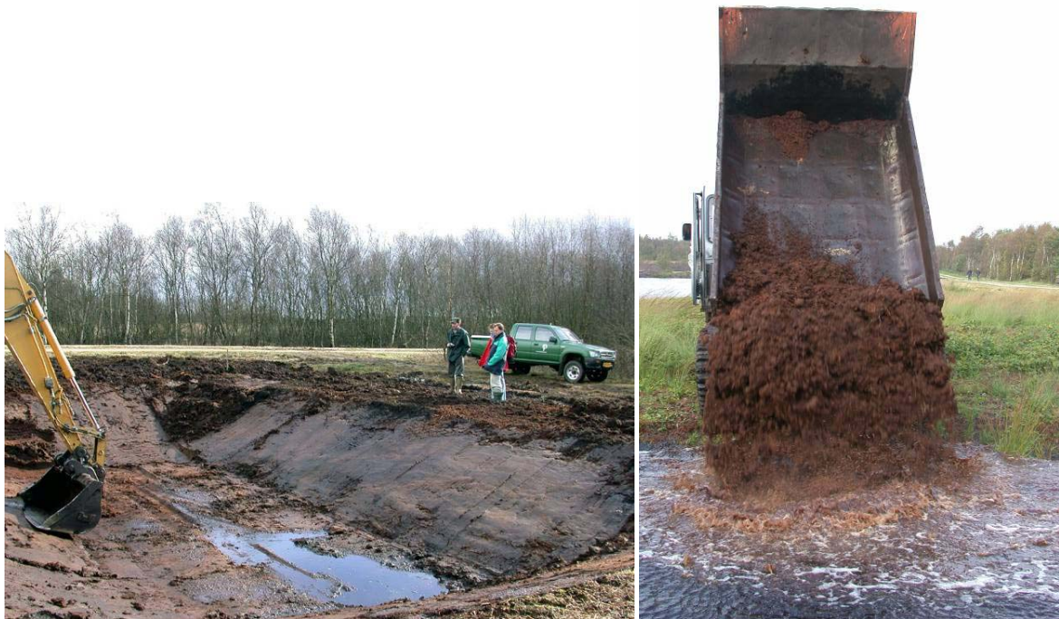
Figuur 32. Opschaling van experimentele drijftilvorming via de introductie van veensubstraat: in februari 2004 zijn hiervoor in het verveende deel van het Meerstalblok (Bargerveen) vijf zwartveenputten gegraven van 5 bij 10 meter (links) waar in september 2004 witveen is ingebracht (rechts).
