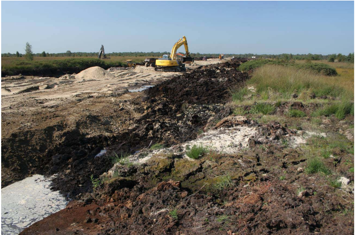
Figuur 17. In de afgelopen decennia zijn vele kilometers kade aangelegd in Nederlandse hoogveenrestanten om daarmee compartimenten te creëren waarbinnen een voor hoogveenvorming zo gunstig mogelijk waterregime gehanteerd kan worden.
