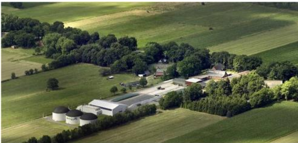
Figuur 8 Luchtfoto: 1,000 kW covergistinginstallatie met één propstreamvergister.
