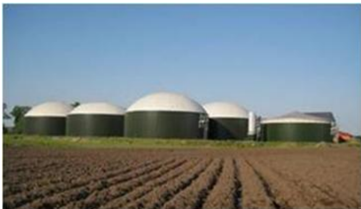
Figuur 9 Biogreen - Heeten, NL 2,000 kWe covergistinginstallatie met 2 propstroomvergisters.
