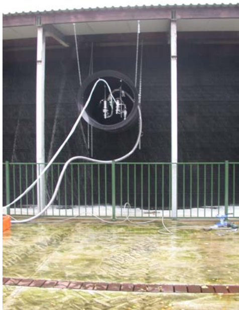
Meetpunt A, uitgaande lucht waterwasser. De cyclonen voor fijnstof en de monsternaleidingen zijn in de koker geplaatst zodat alleen uitgaande lucht van de waterwasser wordt gemeten en geen buitenlucht.
