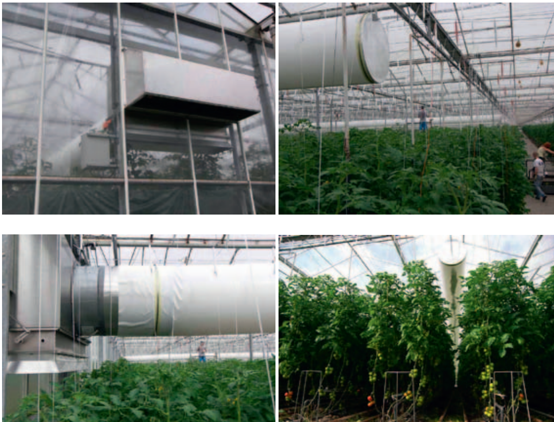
Figuur 6. Systeem met buitenluchtinblaas bij Van Schie (Foto's Groenten & Fruit, Boonekamp).
