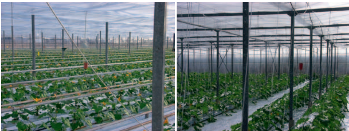
Figuur 1. Aangebracht vast plastic foliescherm bij stookteler (links) en heteluchteler (rechts).
