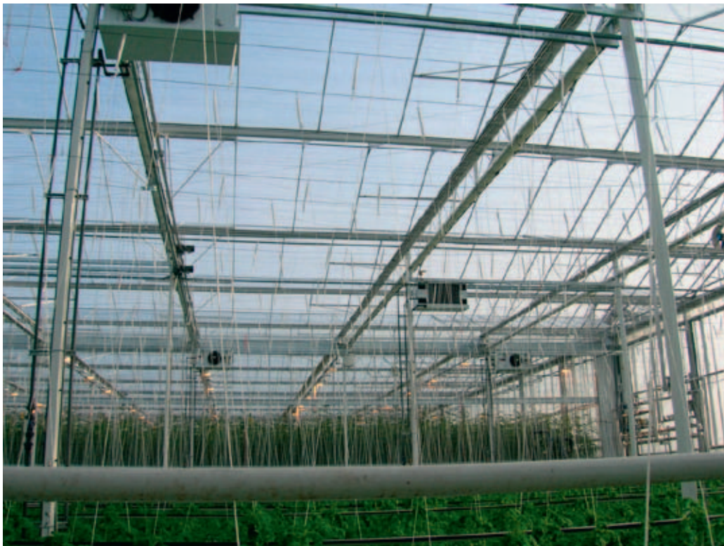
Figuur 4. Koelunits, geïnstalleerd boven het gewas.
