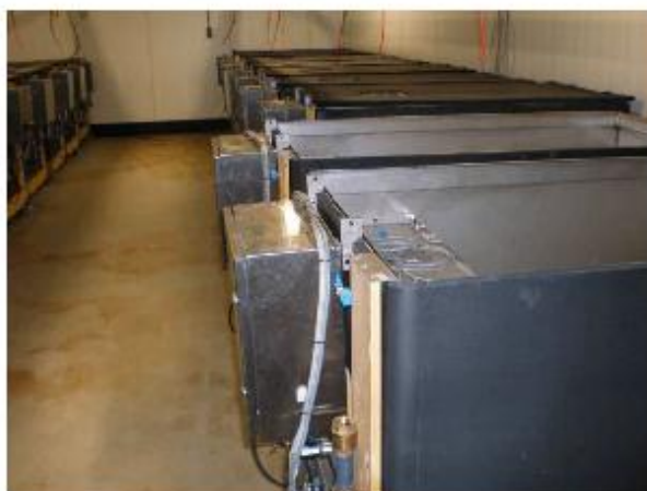
Figuur 1. CA-cellen voor beheersing van de luchtsamenstelling en temperatuur
