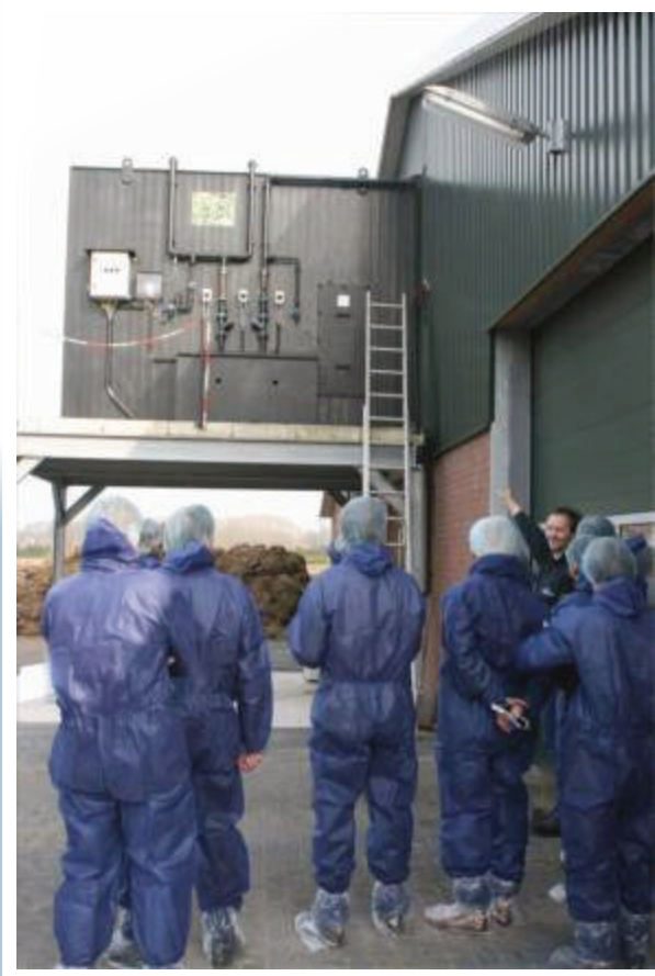
Biologische luchtwasser. Deze luchtwasser zorgt voor 70% emissiereductie ten opzichte van een stal zonder emissiereducerende maatregelen.
