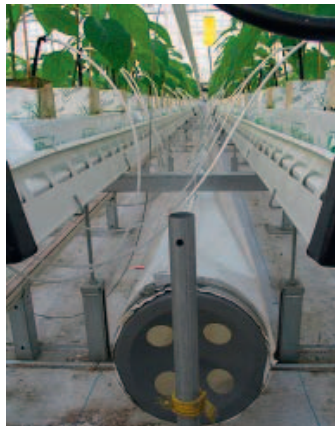
Figuur 2.1. Luchtbehandelingskasten (LBK's) met aanzuigslangen (linksboven en rechtsboven); inwendige van LBK koperen pijpen waar warmte uit de lucht wordt overgedragen aan koelwater (linksonder); slang voor luchtverdeling onder het gewas (rechtsonder).
