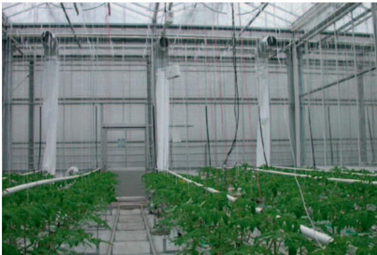
Figuur 2.2. Slurven boven het gewas voor de inblaas van koele lucht.
