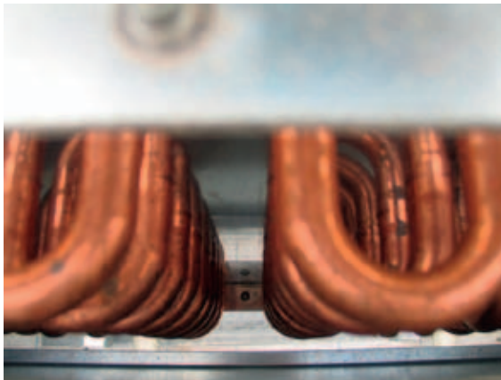
Figuur 2.1. Luchtbehandelingskasten (LBK's) met aanzuigslangen (linksboven en rechtsboven); inwendige van LBK koperen pijpen waar warmte uit de lucht wordt overgedragen aan koelwater (linksonder); slang voor luchtverdeling onder het gewas (rechtsonder).
