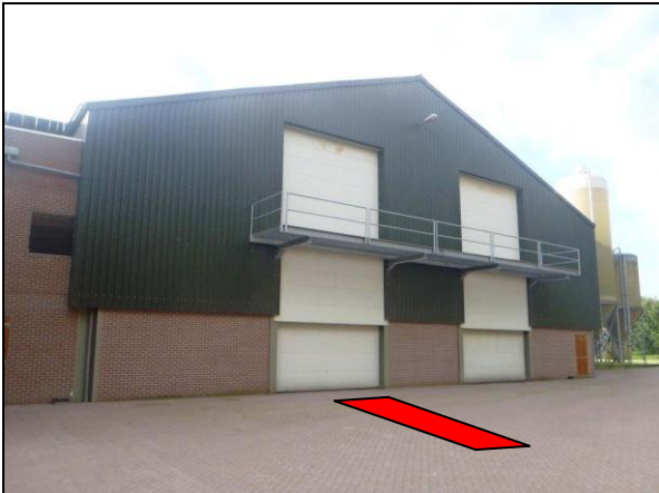
Voorgevel, met positionering ionisatiefilter
