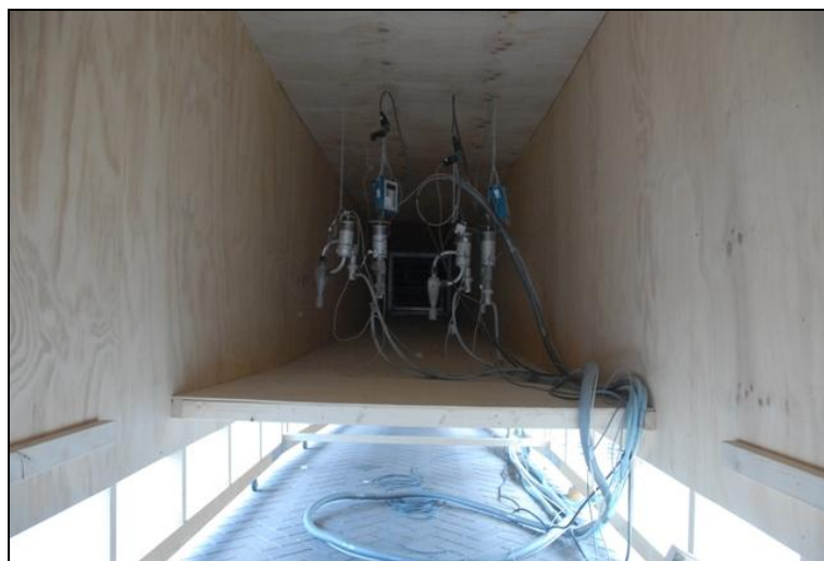
Detailfoto van het meetpunt in het kanaal van meetopstelling 2. Foto genomen vanuit de achterzijde/uitstroomopening van het piramidevormige kanaal naar voren toe.
