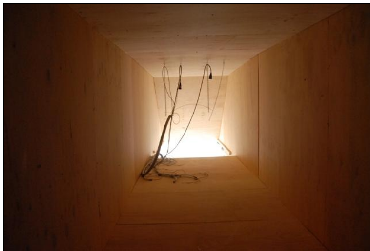
Detailfoto van het meetpunt in het kanaal van meetopstelling 2. Foto genomen vanuit de voorzijde/aanstroomzijde van het pyramidevormige kanaal naar de uitstroomopening toe. Op de achtergrond zijn de windkap en de uitstroomopening in de bodem van het kanaal zichtbaar. De diameter van het kanaal neemt naar achteren (naar de uitstroomopening) toe
