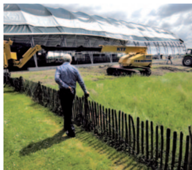
↑ NU HET DAK NOG EVEN. DE EERSTE FLEXHAL IN LIPPENHUIZEN (FRIESLAND).
