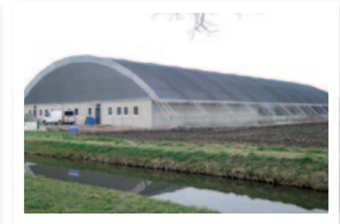
↑ DE BOOGHAL HEEFT DANKZIJ DE SPANTVORM EEN ISOLERENDE LAAG TUSSEN PVC-FOLIE EN HET SCHADUWDOEK ER BOVEN. FOTO: BOOGHAL BV
