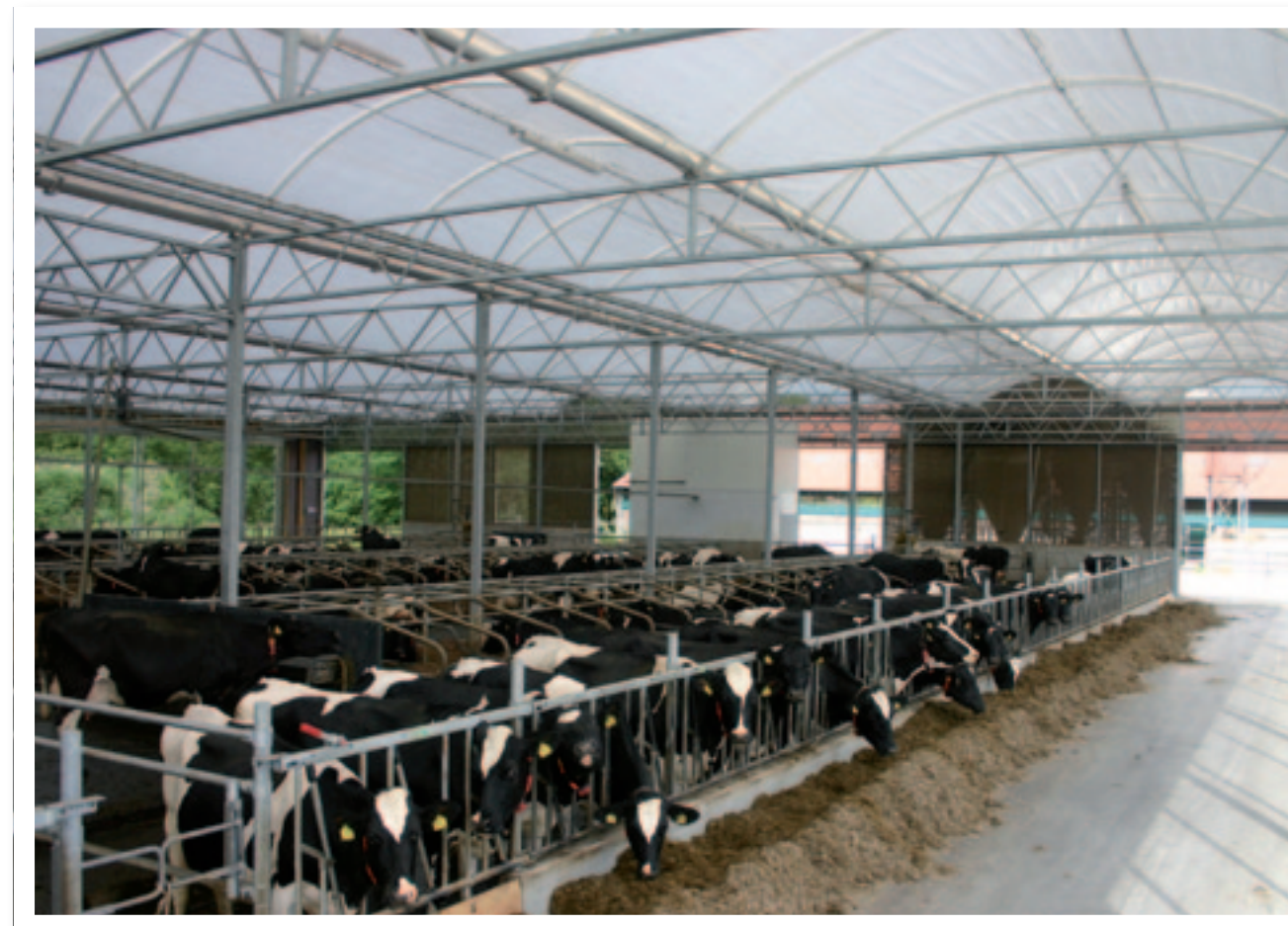
↑ UITBUNDIG LICHT EN ENORM VEEL DWARSENTILATIE IN DE SERRESTAL VAN REUVEKAMP. FOTO: DIEDERIK SLEURINK
