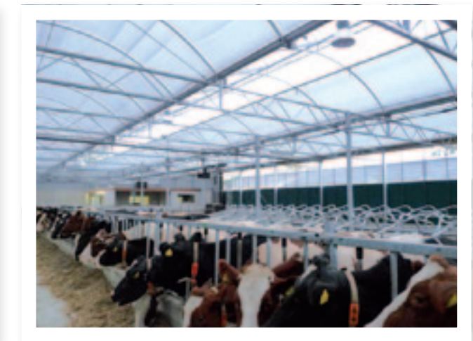
↑ WARMTE LUCHT ZIT TEGEN HET DAK EN IS METEEN WEG ALS DE KAP VAN DE SERRESTAL OPEN DRAAIT. FOTO: ID AGRO
