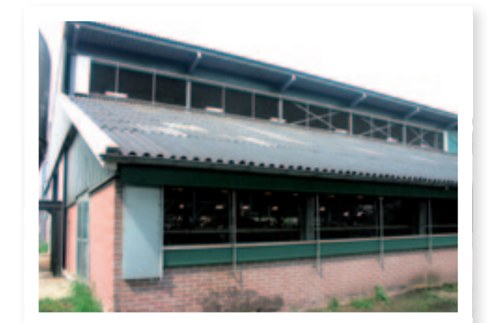
↑ DE NIEUWE EN OUDE STAL VORMEN NU ÉÉN GEBOUW. WAAR VROEGER DE NOK ZAT IS NU DE GROTE LUCHT- EN LICHTINLAAT VAN HET EERSTE DAK.
