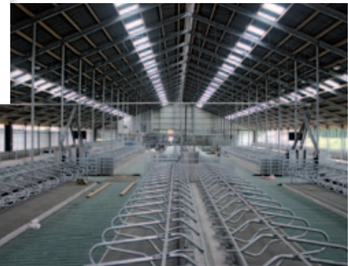
↑ HET DAK VAN DE NIEUWE STAL VAN MTS. PIERIK BEGINT 1,50 METER BOVEN DE GOOT VAN DE OUDE, ZODAT DAAR LICHT EN LUCHT BINNENKOMT.
