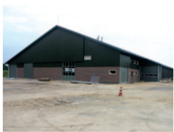
↑ DE STAL MET 300 BOXEN EN EEN 2 x 30 SWING OVER MELKSTAL VAN MAATSCHAP WEERINK. AFMETINGEN 112 x 40 METER, GOOTHOOGTE 4 METER, NOKHOOGTE 12 METER. GOLFPLATEN IN PLAATS VAN SANDWICH EN EEN GOEDKOPE OVERSTEK-NOK SCHEELT ZEKER 70.000 EURO, SCHAT DENNIS WEERINK.
