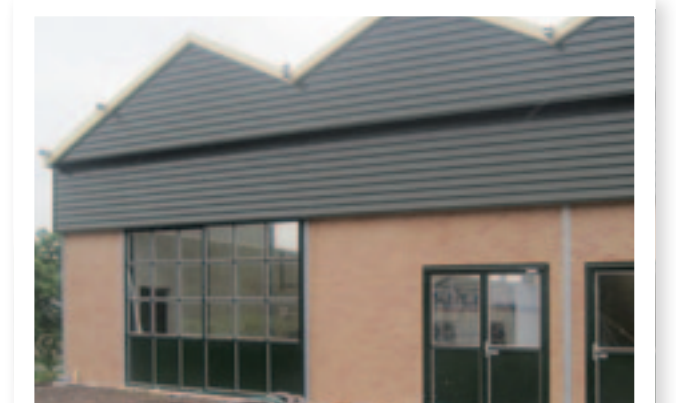
↑ DEZE V-STAL KREEG EEN AANGEPASTE VOORGEVEL DIE DE KASACHTIGE VOORZIJDEN CAMOUFLEERT.
