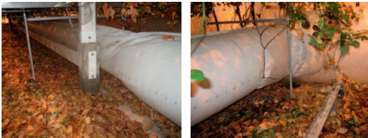
Figuur 2.12. Niet strak hangende luchtslangen.
