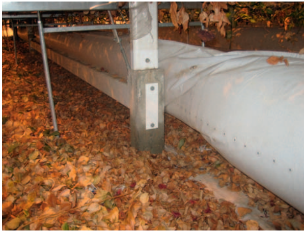
Figuur 2.22. Slang 1 hangt tegen de spantpoot.
