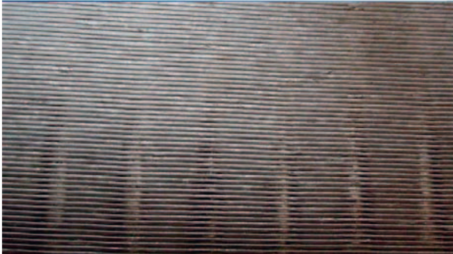
Figuur 2.10. Schoongemaakt verwarmingsblok.
