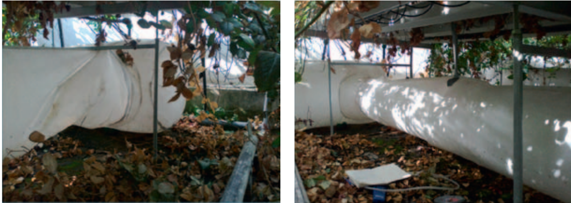
Figuur 2.20. Geperforeerde slang 6 met (links) en zonder knik (rechts).
