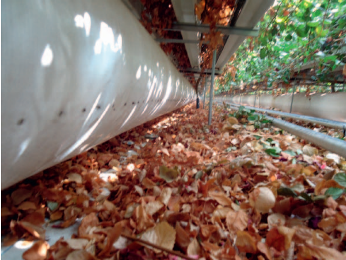
Figuur 2.7. Perforaties in de inblaasslangen.
