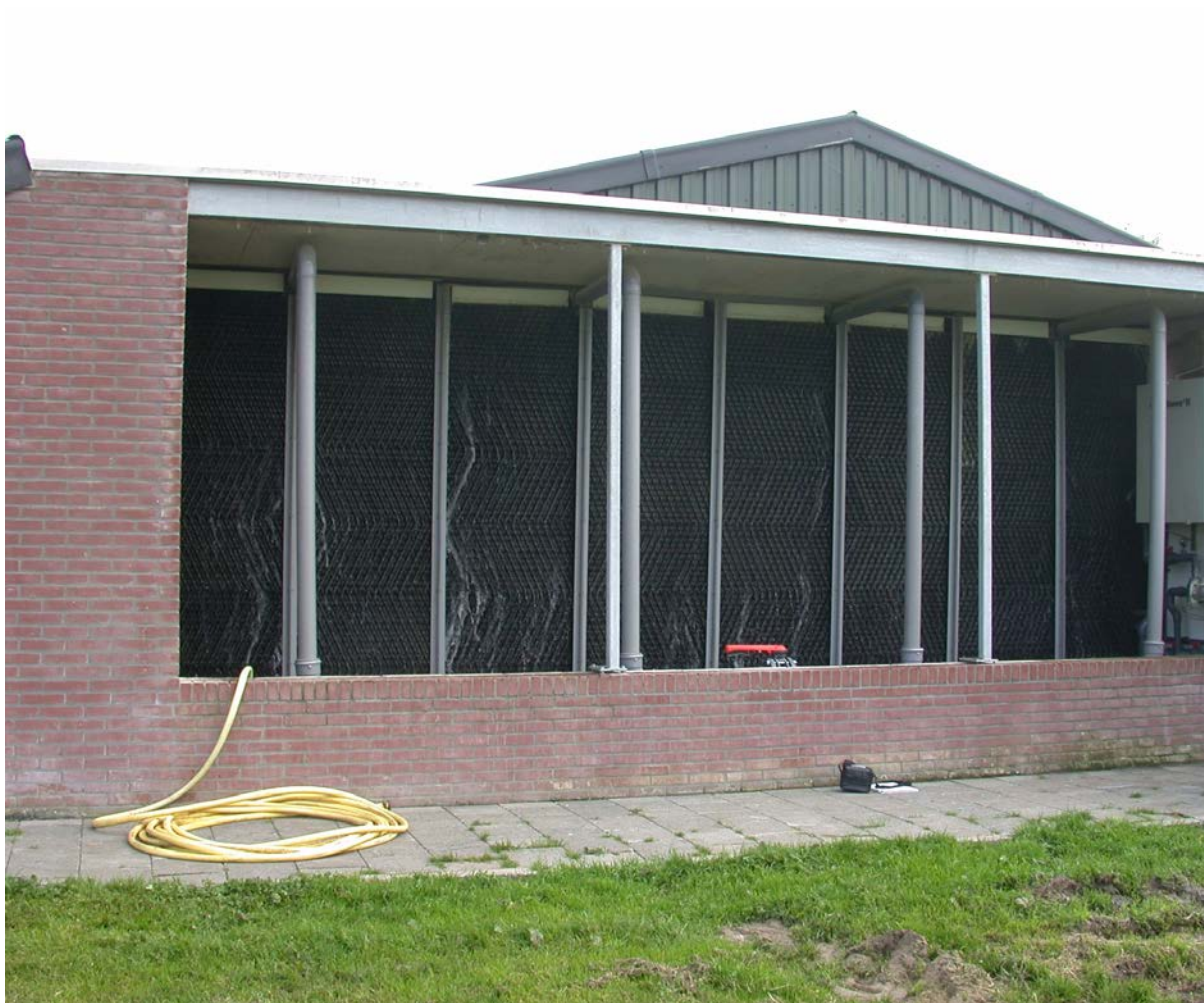
Figuur 3 Buitenaanzicht van de experimentele biologische luchtwasser met denitrificatie (wasser 1).
