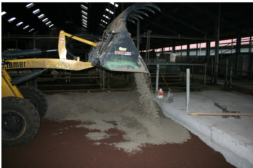
Foto 1 Impressie van de aanleg van de zandstal. Rechts het betonnen vreetgedeelte. Het lavaliet is duidelijk te onderscheiden van de zandlaag.
